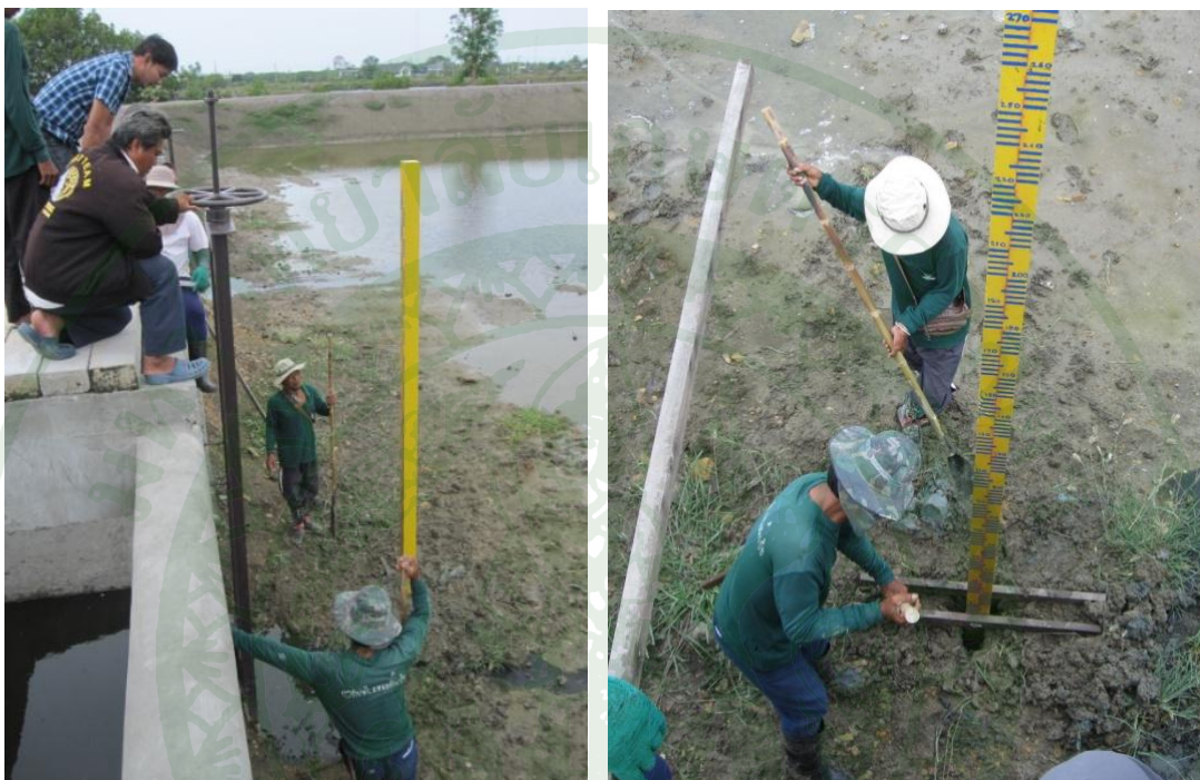
ภาพที่ 42 ไม้วัดระดับน้ำและการติดตั้ง
