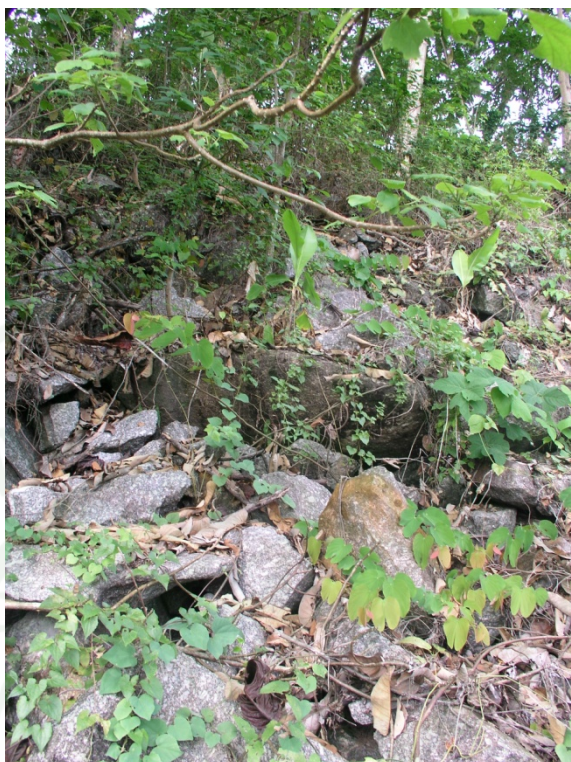
ภาพที่ 45 แสดงหินทิ้งขนาดใหญ่บริเวณหน้า Slope ด้านล่าง
