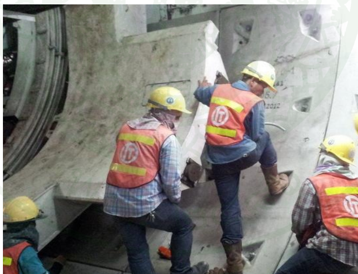
ภาพที่ 48 การติดตั้งคาดผนังอุโมงค์
