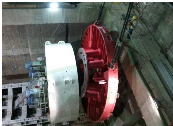
ภาพที่ 43 การติดตั้งเครื่องขุดเจาะอุโมงค์
