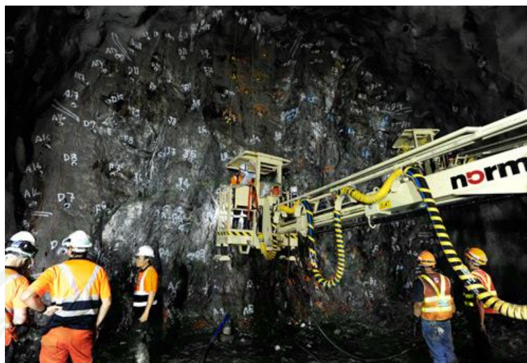
ภาพที่ 2 การก่อสร้างอุโมงค์หินด้วยวิธี Drilling and blasting method
