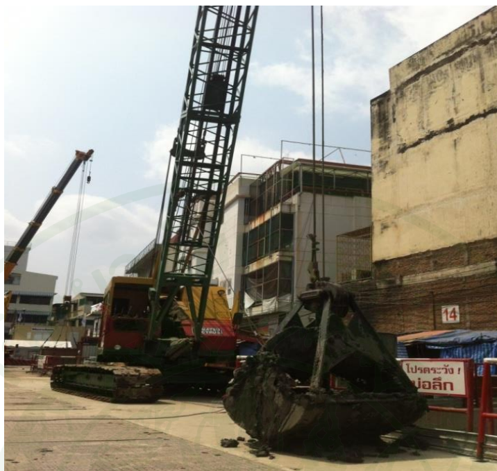
ภาพที่ 57 ปั่นจั่นชนิดเคลื่อนที่ล้อยตีนตะขาบ 50 ตัน ติดตั้งหัวตักแบบ Clamshell
