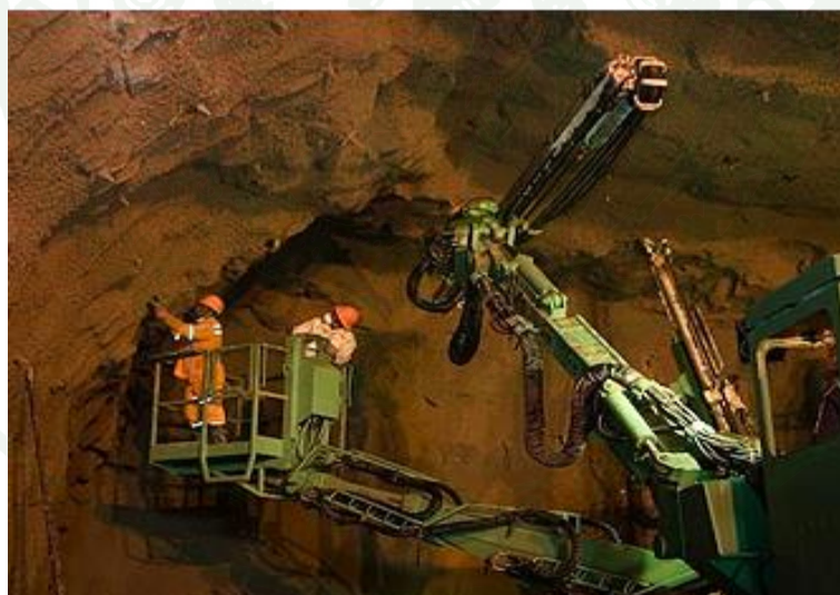
ภาพที่ 3 การก่อสร้างอุโมงค์ดินด้วยวิธี Drilling and blasting method
