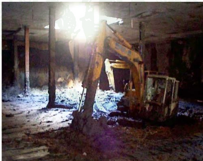
ภาพที่ 56 การขุดดินภายในสถานีรถไฟฟ้าใต้ดิน
