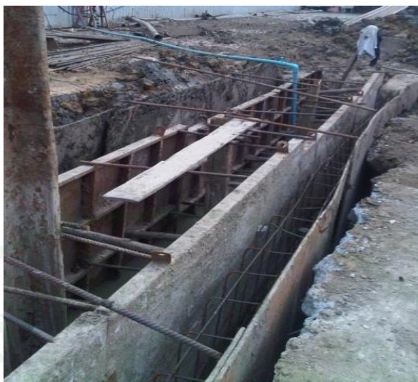
ภาพที่ 26 การก่อสร้างแนวกำแพงทึบน้ำ (Guide wall)
