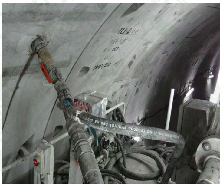
ภาพที่ 49 การอัดฉีดน้ำปูน
