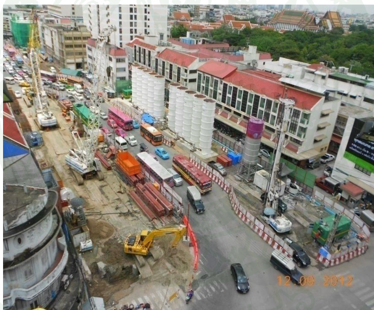
ภาพที่ 54 การวางตำแหน่งเครื่องจักรของงานก่อสร้างกำแพงที่บ้น้ำ
