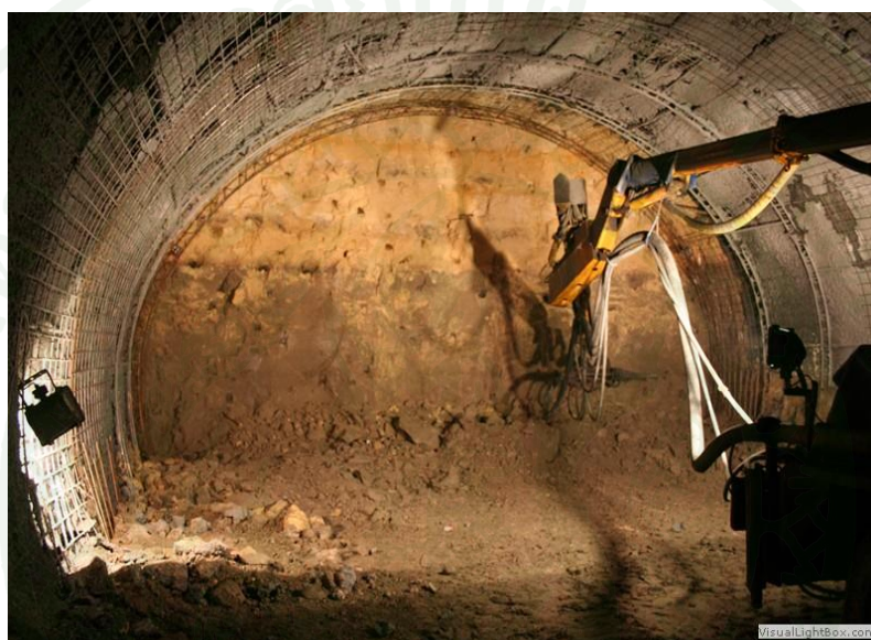
ภาพที่ 4 การก่อสร้างอุโมงค์ด้วยวิธี New Austrian tunneling method (NATM)
