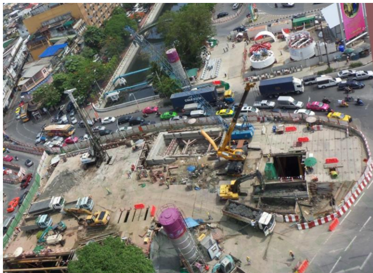
ภาพที่ 40 บริเวณปล่องอุโมงค์ (Shaft)
