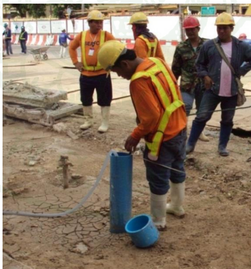
ภาพที่ 33 การทดสอบ sonic logging test
