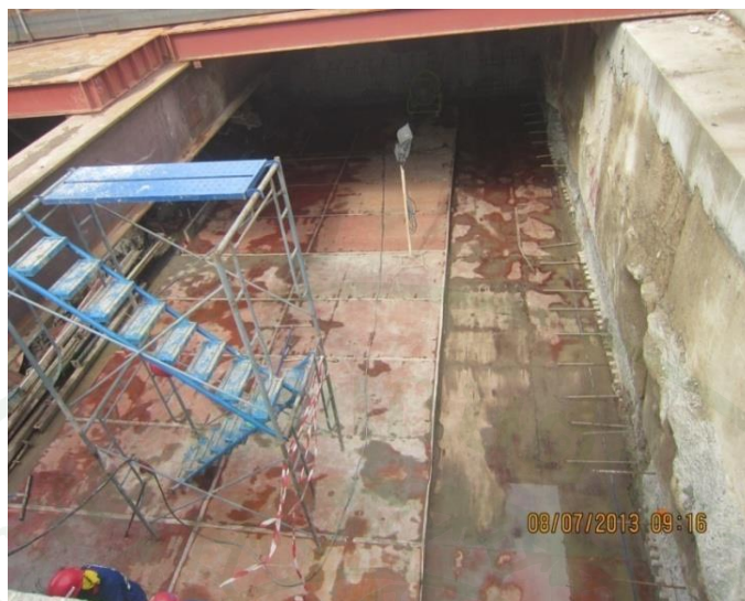
ภาพที่ 55 ช่องเปิด (opening) ในงานก่อสร้างสถานีรถไฟฟ้าใต้ดิน
