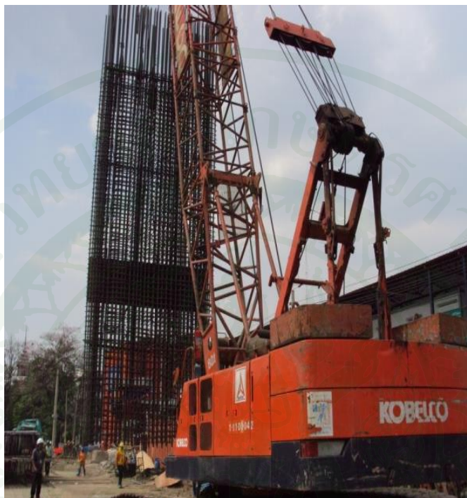
ภาพที่ 29 การติดตั้งเหล็กเสริม
