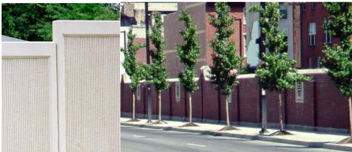
ภาพที่ 50 กำแพงป้องกันเสียงรบกวน ประเภทคอนกรีต และ Brick Block ตามลำดับ
