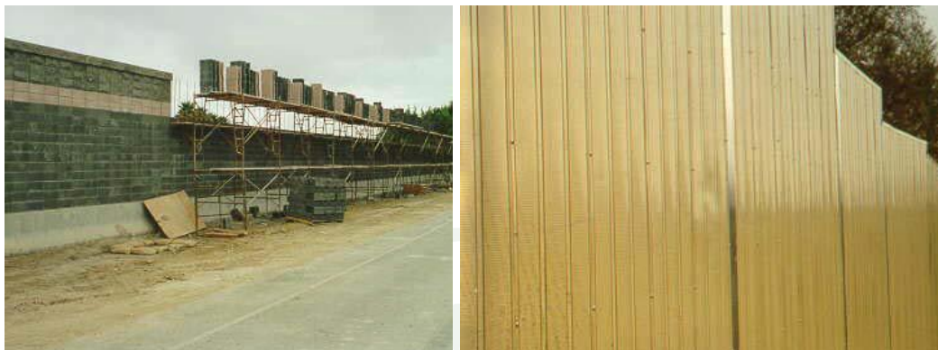
ภาพที่ 51 กำแพงป้องกันเสียงรบกวน ประเภท Masonry Block และโลหะผสม
