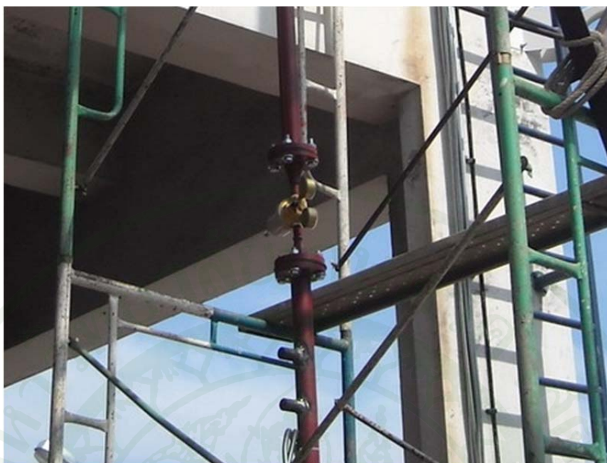
ภาพที่ 46 ต่อเข้ากับอุปกรณ์ควบคุมความดัน (Pressure Regulator)
