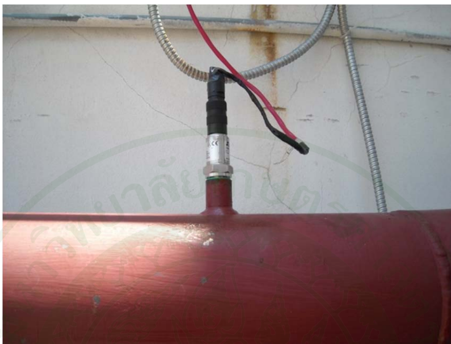
ภาพที่ 88 การติดตั้งตัวอุปกรณ์ส่งสัญญาณเข้ากับข้อต่อตรงเกลียว
