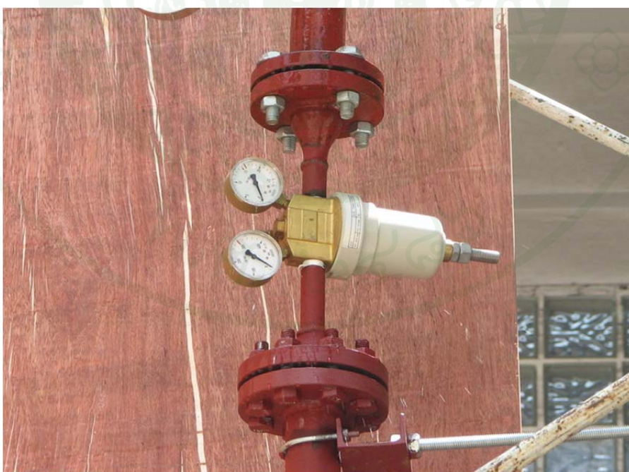
ภาพที่ 116 ติดตั้งชุดอุปกรณ์ลดแรงดันเข้ากับระบบท่อ
