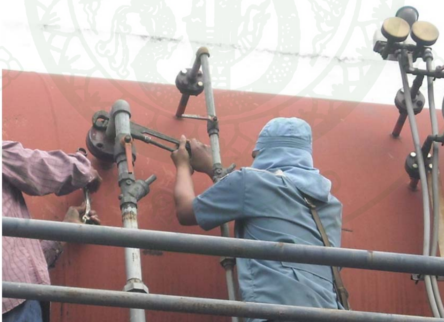
ภาพที่ 52 การถอดท่อและอุปกรณ์ต่างๆ
