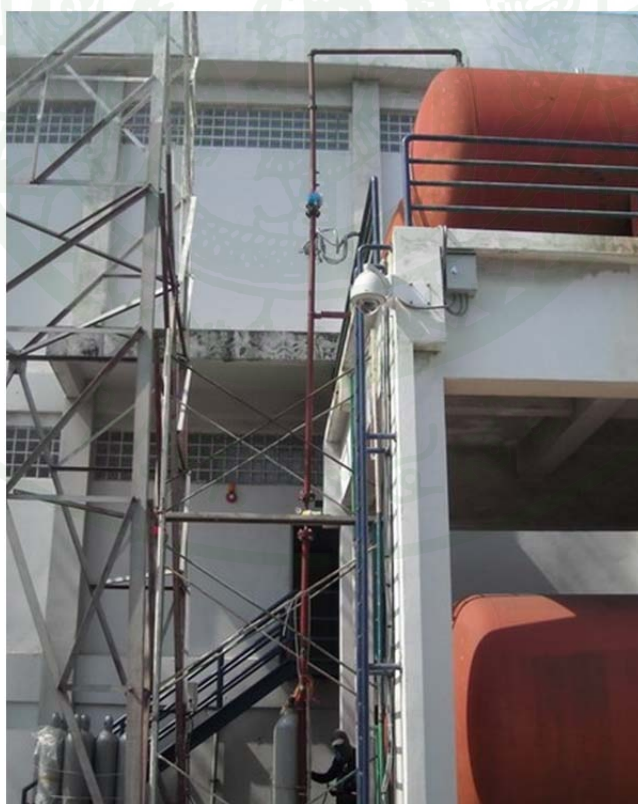
ภาพที่ 47 ให้ท่อในแนวตั้งตั้งตรง
