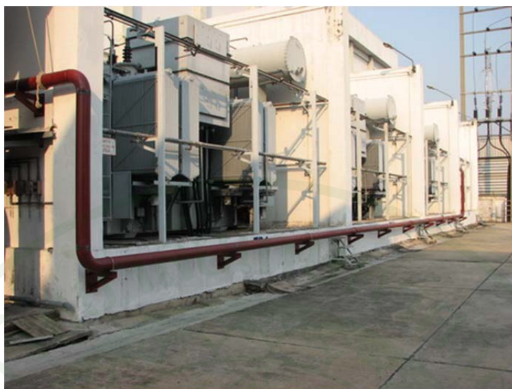
ภาพที่ 84 ท่อที่เชื่อมต่อกันเสร็จแล้ว
