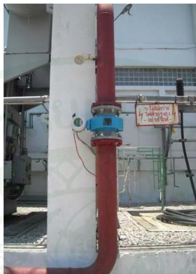
ภาพที่ 86 การติดตั้งอุปกรณ์ส่งสัญญาณค่าอัตราการไหลของน้ำ
