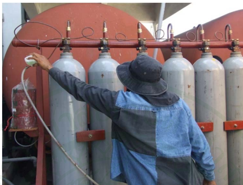
ภาพที่ 149 เหนี่ยวาล้างงานที่จุดเชื่อมต่อท่อทองแดง
