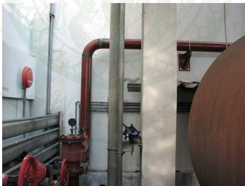
ภาพที่ 83 ท่อที่เชื่อมต่อกับวาล์วควบคุมการสั่งงาน(Deluge Valve)
