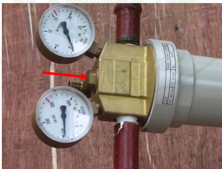
ภาพที่ 154 ตำแหน่งที่เปิดเอาลิ้นวาล์วมาตรวจสอบ
