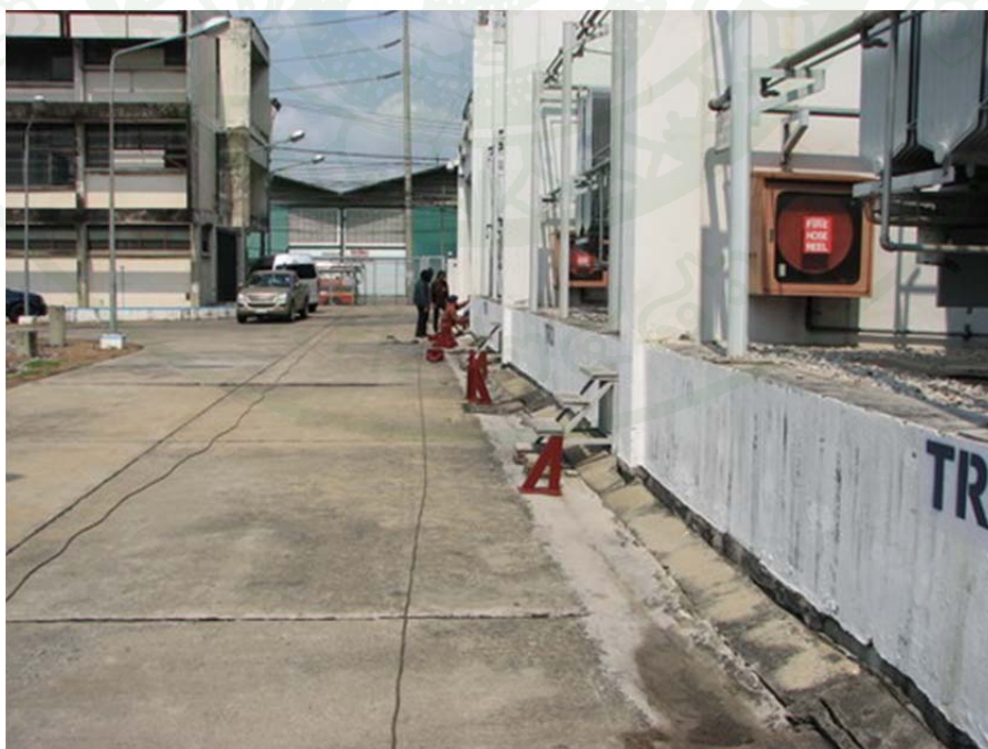
ภาพที่ 77 ระยะและระดับของฐานรองรับท่อ (Support) แต่ละตัว
