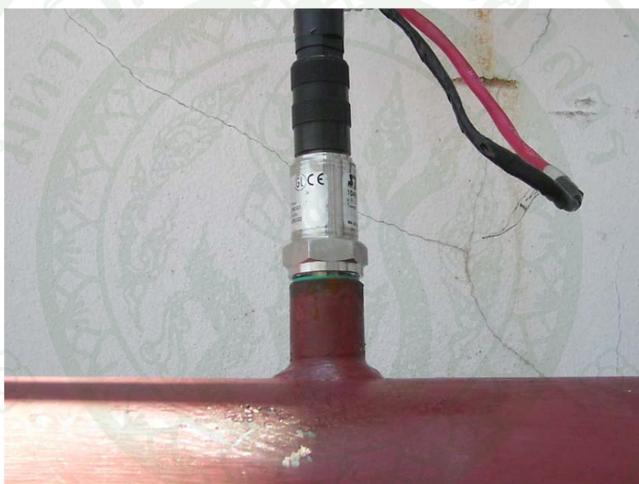
ภาพที่ 66 การติดตั้งตัวอุปกรณ์ส่งสัญญาณเข้ากับข้อต่อตรงเกลียว
