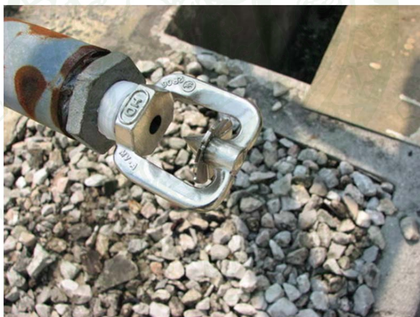
ภาพที่ 75 การติดตั้งหัวกระจายน้ำฝอยใหม่
