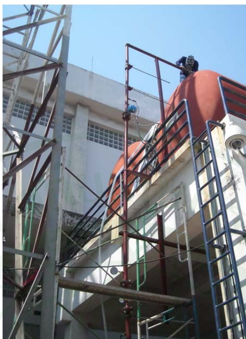
ภาพที่ 48 เสริมเหล็กรองรับท่อ (Support) ให้แนวท่อมีความแข็งแรง
