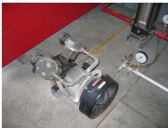
ภาพที่ 14 เครื่องอัดลมเพื่อเพิ่มแรงดันในถังเก็บน้ำความดัน
