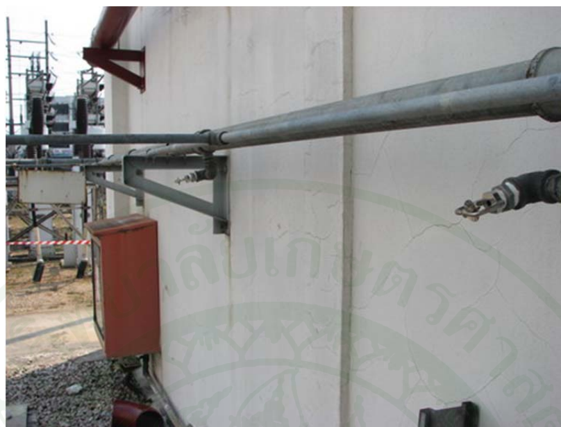
ภาพที่ 74 การติดตั้งหัวกระจายน้ำฝอยใหม่
