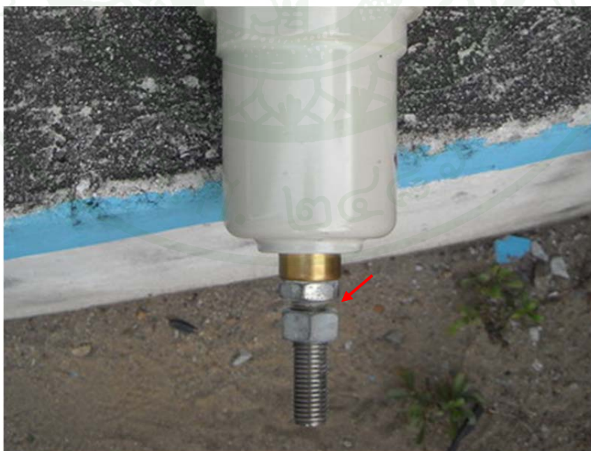
ภาพที่ 114 จุดขันปรับแรงดัน
