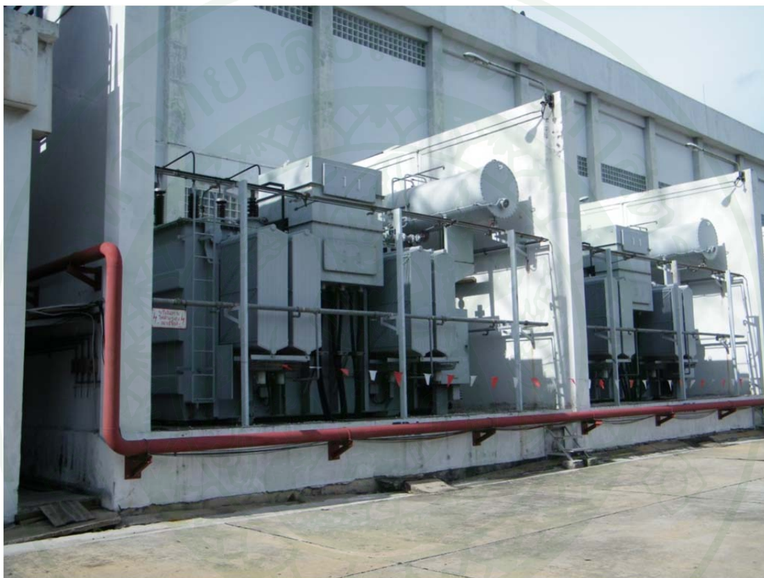
ภาพที่ 19 ลักษณะการติดตั้งหม้อแปลง
