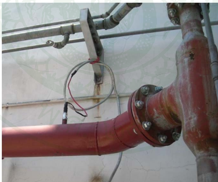
ภาพที่ 89 การติดตั้งตัวอุปกรณ์ส่งสัญญาณเข้ากับข้อต่อตรงเกลียว
