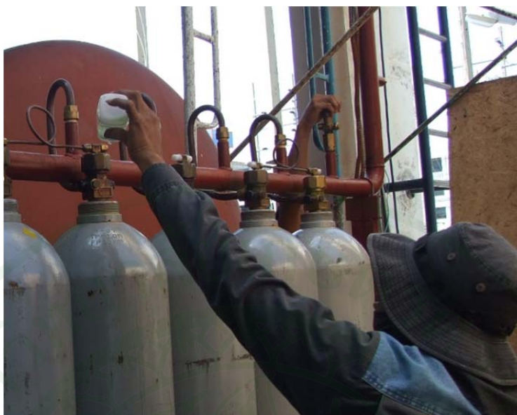
ภาพที่ 145 เหนี่ยาล้างจานผสมน้ำตรวจตามจุดเชื่อมต่อ
