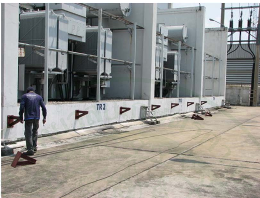
ภาพที่ 78 การยึดฐานรองรับท่อ (Support) เข้ากับผนัง
