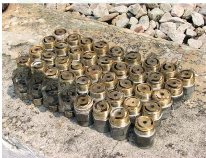
ภาพที่ 73 ทำการถอดหัวกระจายน้ำฝอยของเดิมออกทั้ง 44 หัว
