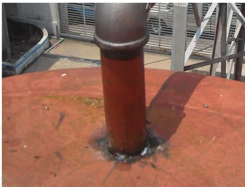
ภาพที่ 63 การเชื่อมต่อท่อของไนโตรเจนเข้ากับถังน้ำ
