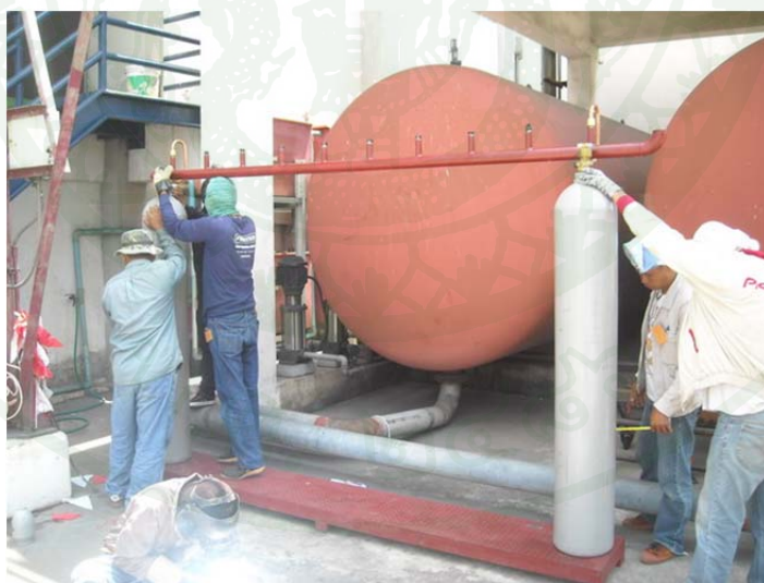
ภาพที่ 41 นำท่อร่วมขึ้นทหาระยะและระดับที่จะตั้งถังเก็บไนโตรเจน
