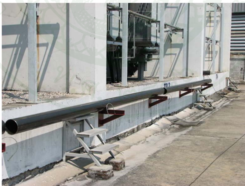
ภาพที่ 79 นำท่อที่ติดตั้งขึ้นวางเรียงยาวต่อกัน
