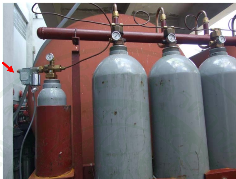
ภาพที่ 111 ติดวาล์วไฟฟ้า (Solenoid Valve) เข้ากับถังสั่งฉีด (Pilot Cylinder)
