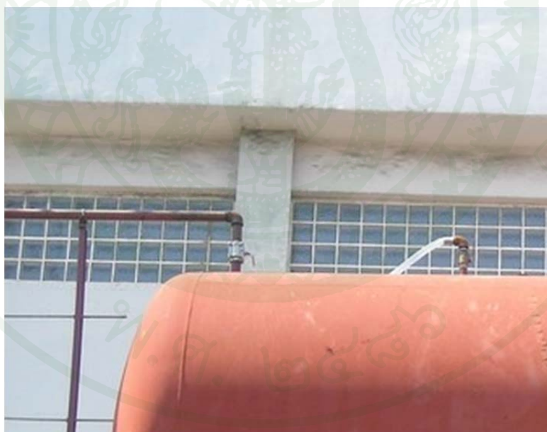
ภาพที่ 64 ติดตั้งบอลวาล์ว (Ball valve)
