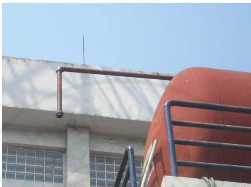
ภาพที่ 44 ติดตั้งท่อที่ต่อเข้ากับถังน้ำด้านบนลงมายังเก็บไนโตรเจน
