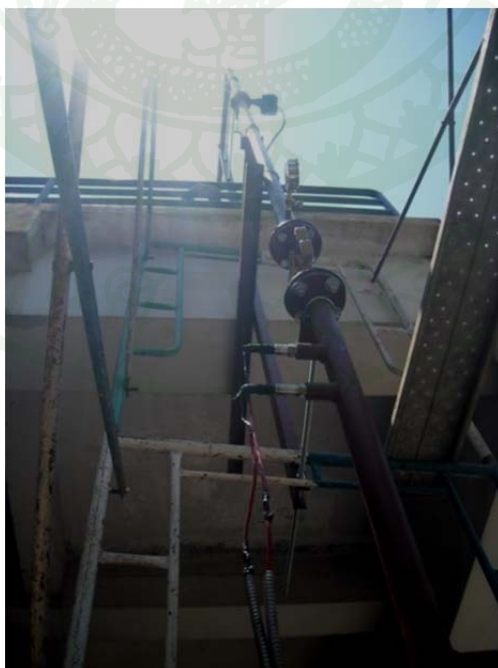
ภาพที่ 49 ติดตั้งอุปกรณ์ส่งสัญญาณทั้งหมด
