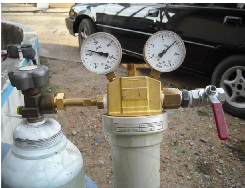
ภาพที่ 113 ต่อถังไนโตรเจนเข้ากับอุปกรณ์ลดแรงดัน
