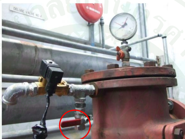
ภาพที่ 105 วาล์วควบคุมการสั่งงาน (Deluge Valve)
