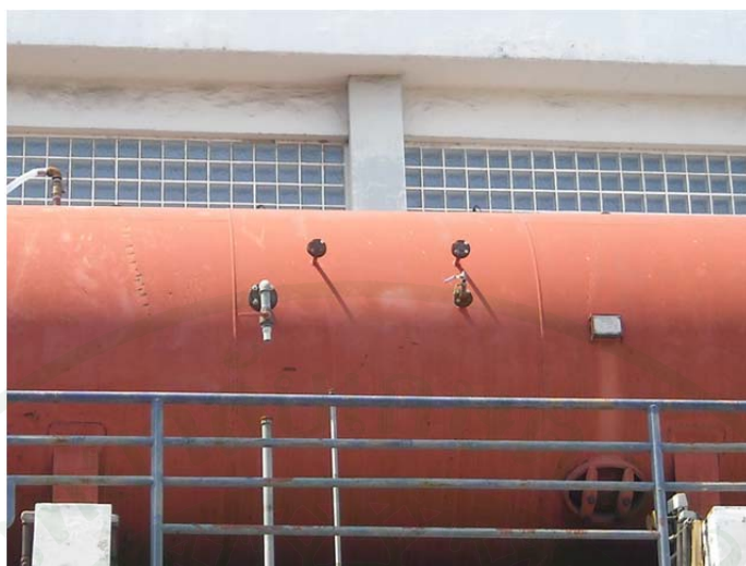
ภาพที่ 53 ใช้หน้าแปลนเหล็กปิดที่รูเดิม
