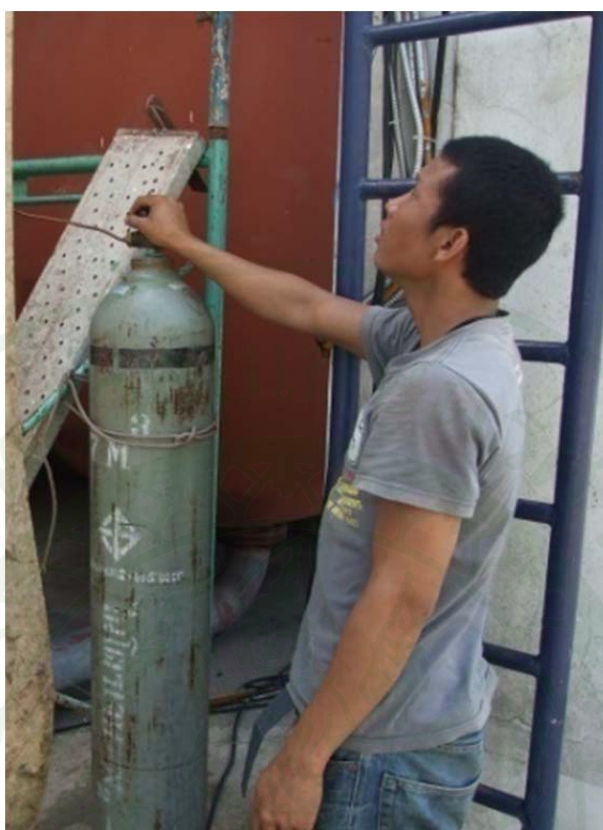
ภาพที่ 143 ถังไนโตรเจนสำหรับทดสอบการรั่วกับวาล์วทดสอบ
