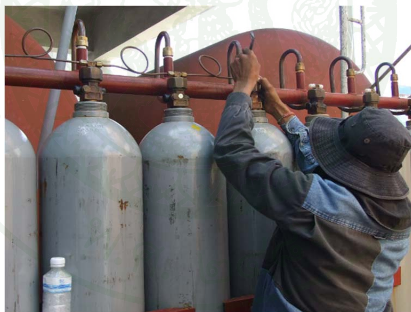
ภาพที่ 150 สังเกตฟองอากาศที่ออกมาและทำการแก้ไข
