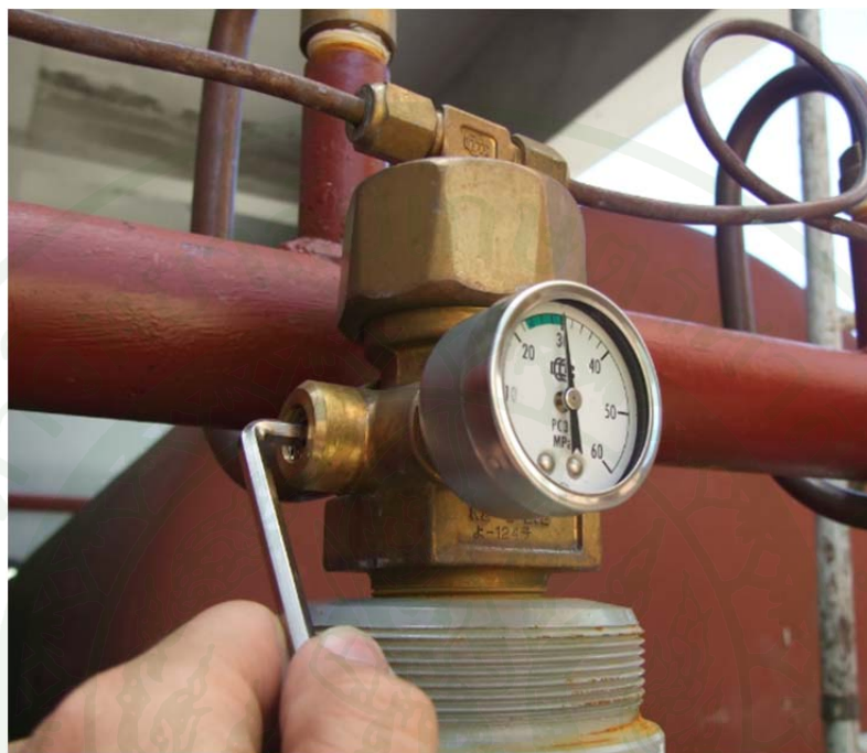
ภาพที่ 109 ใช้ประแจหกเหลี่ยมขันเปิดวาล์วเช็คแรงดัน
