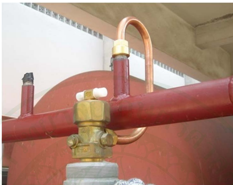
ภาพที่ 42 ต่อท่อโค้งทองแดง (Loop pipe) เข้ากับท่อร่วม (Header Pipe)
