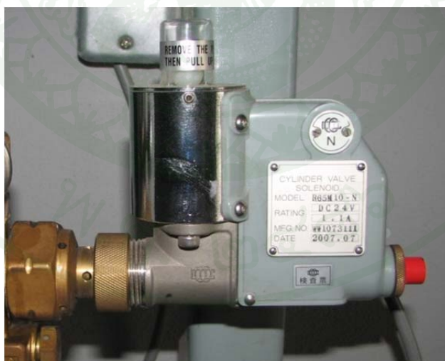
ภาพที่ 34 วาล์วไฟฟ้าเปิดถัง (Cylinder Valve Solenoid)
