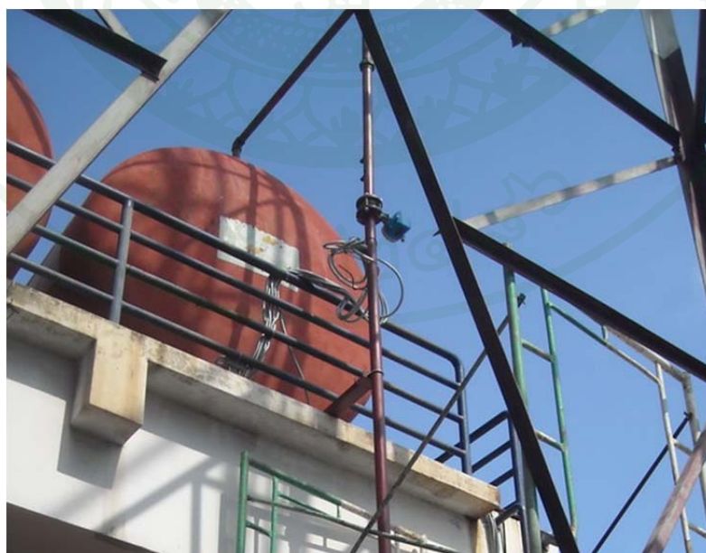
ภาพที่ 45 เชื่อมต่อแนวท่อด้านบนกับอุปกรณ์ส่งสัญญาณ
