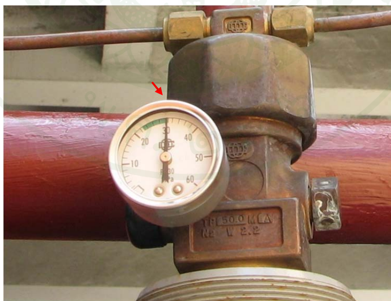
ภาพที่ 110 มาตรวัดความดันเช็คแรงดันในถังจะต้องอยู่ในช่วงสีเขียว
