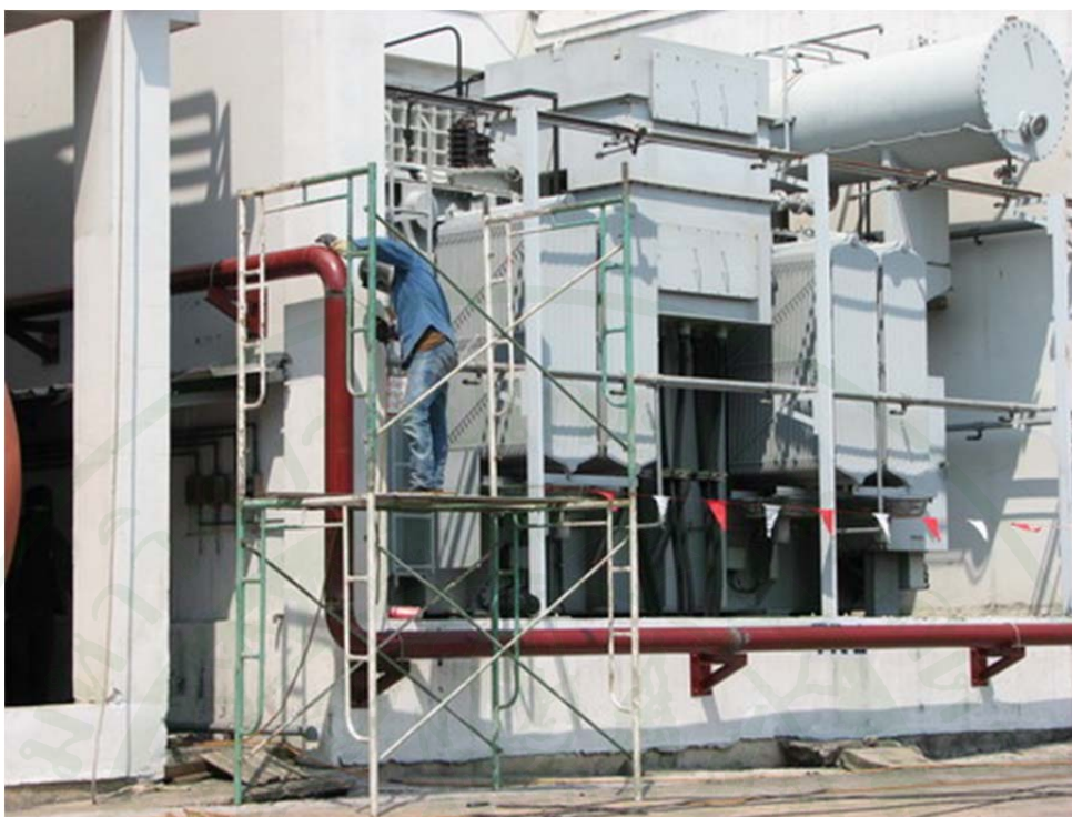
ภาพที่ 82 ท่อที่เชื่อมต่อกันด้านถึงน้ำดับเพลิง
