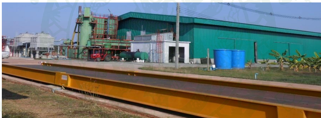
ภาพที่ 8 โรงไฟฟ้าชีวมวลขนาด 1 เมกะวัตต์ ที่มา: โรงไฟฟ้าเพชรภูพาน จังหวัดสกลนคร (2556)
