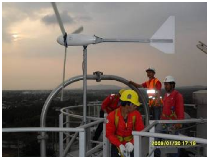
ภาพที่ 6 รูปแสดงการติดตั้งกังหันลมมองจากด้านล่างขึ้นไปยัง SILO
