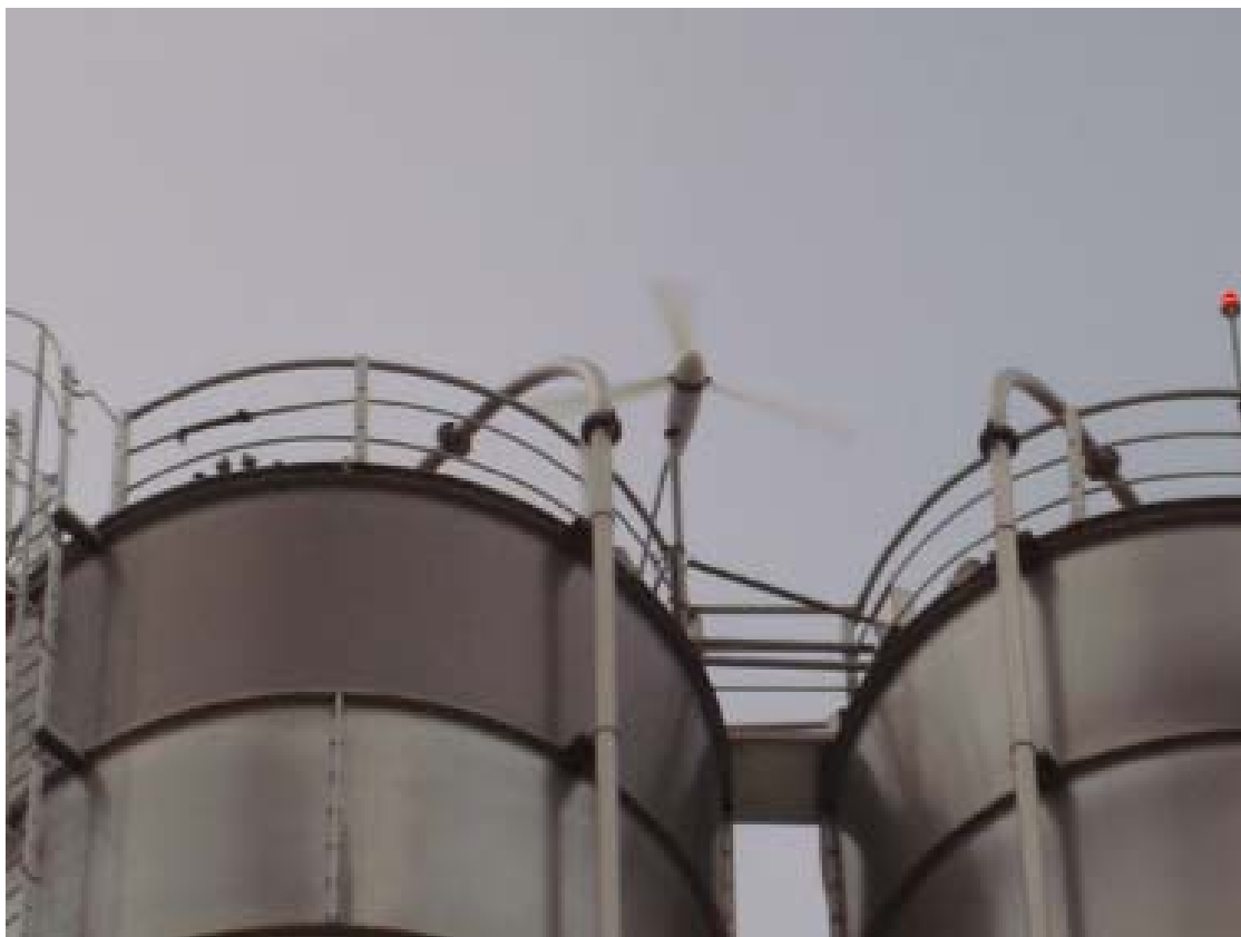
ภาพที่ 4.5 รูปแสดงกังหันลมที่ติดตั้งบน SILO
