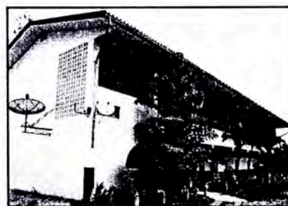
สภาพอาคารเรียน (อาคาร 1)
