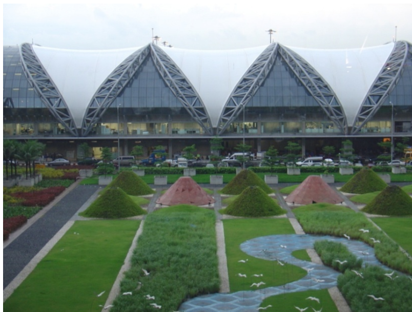
ภาพที่ 5.6 ภายนอกอาคารเทียบเครื่องบิน (2)
