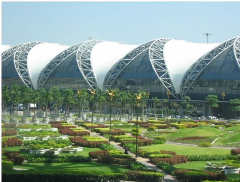
ภาพที่ 5.5 ภายนอกอาคารเทียบเครื่องบิน (1)
