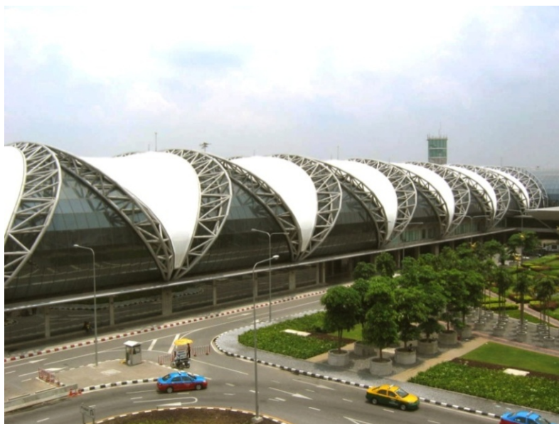
ภาพที่ 5.10 ภายนอกอาคารเทียบเครื่องบิน (3)
