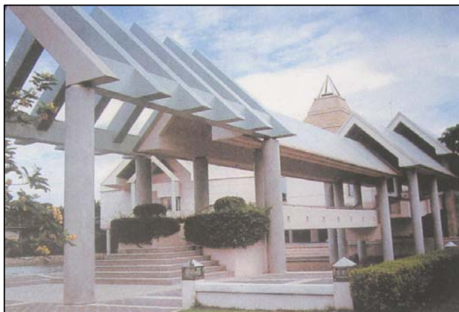
ภาพที่ 2.9 การใช้วัสดุสมัยใหม่มุ่งหลังคา
