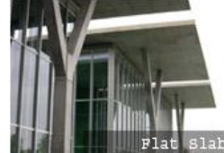
G. หลังคาคอนกรีต
