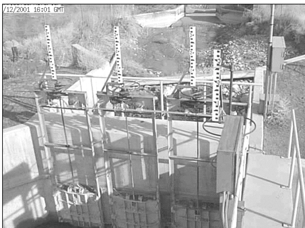
ภาพที่ 16 การตรวจวัดระยะเปิดประตูระบายน้ำ
