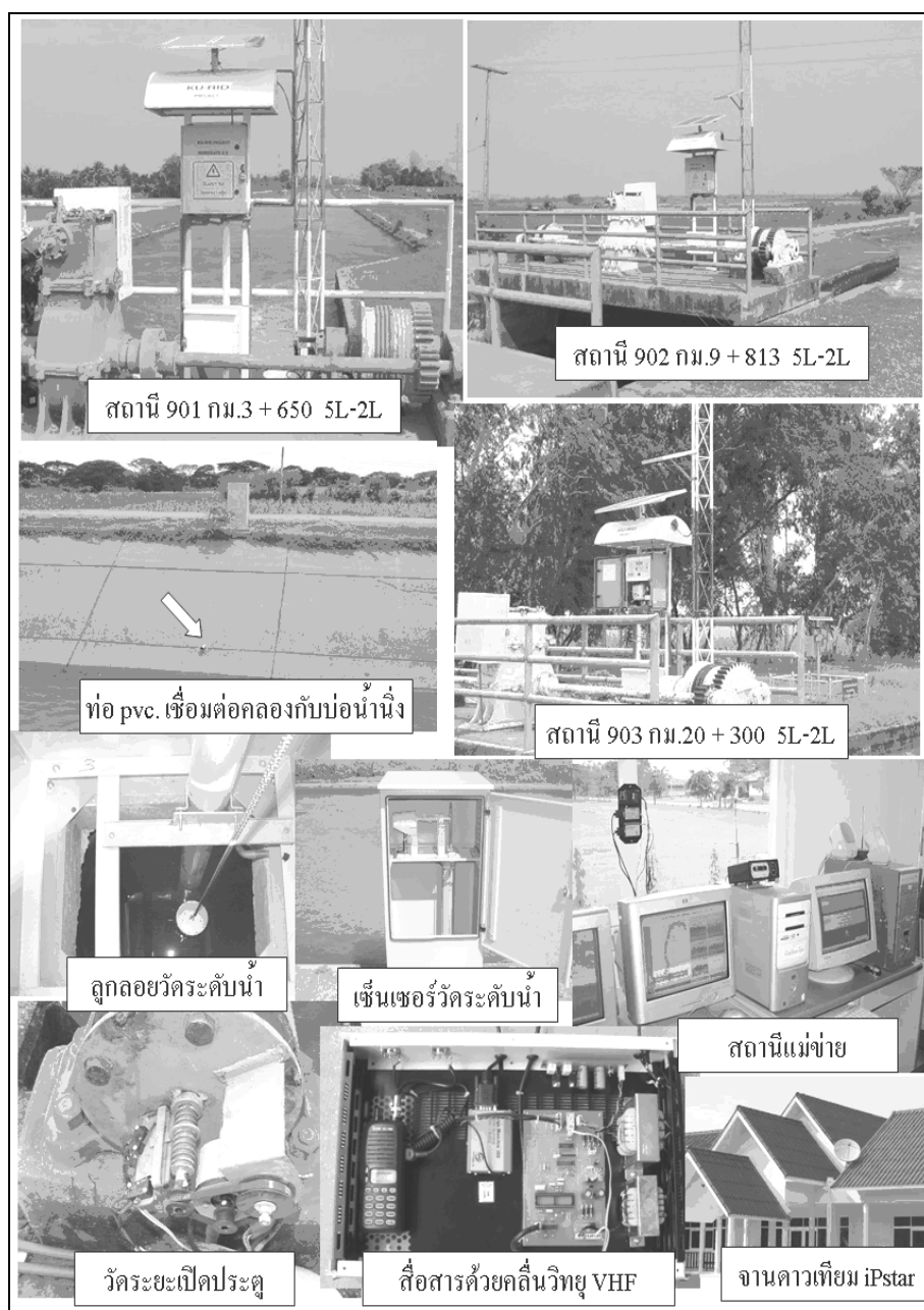
ภาพที่ 29 องค์ประกอบของระบบคลองอัตโนมัติสองพี่น้อง
