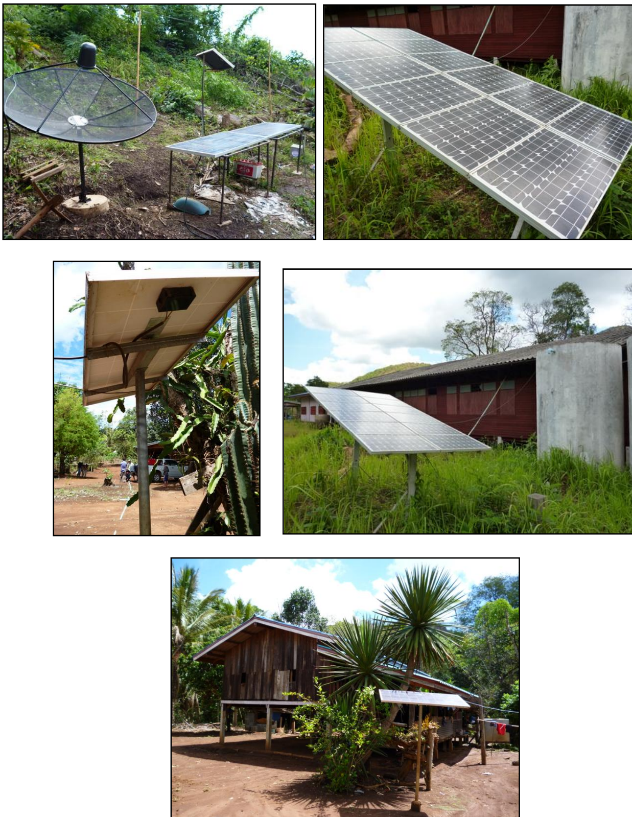
ภาพที่ ค - 5 แสดงระบบผลิตไฟฟ้าพลังงานแสงอาทิตย์เพื่อใช้เอง (Stand-Alone)
