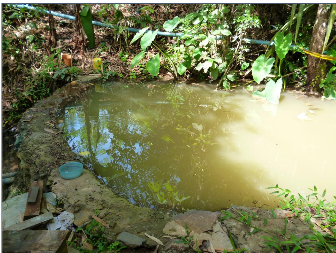
ภาพที่ 4.3 แสดงฝายต้นน้ำลำธารแบบกั้นถาวรชนิดฝายหินก่อบริเวณสำนักสงฆ์บ้านตะเพินคี 1
