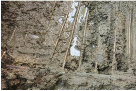
รูปที่ 2 การติดตั้งชุดระบายความร้อนใต้ผิวดินสำหรับระบบไฮโดรโปนิคส์
