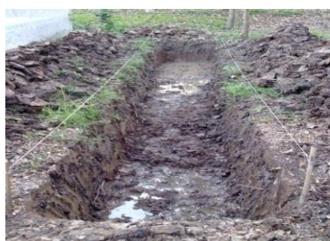
ภาพ 13 แสดงพื้นที่ฝังชุดระบายความร้อนใต้ผิวดินฯ ที่ระดับความลึกจากผิวดิน 1.10 เมตร
