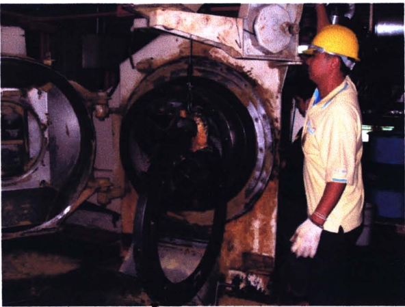
รูป 4.44 การเปลี่ยนตะแกรงโดยใช้รอกช่วยในการยกอะไหล่ที่ต้องถอดประกอบ
