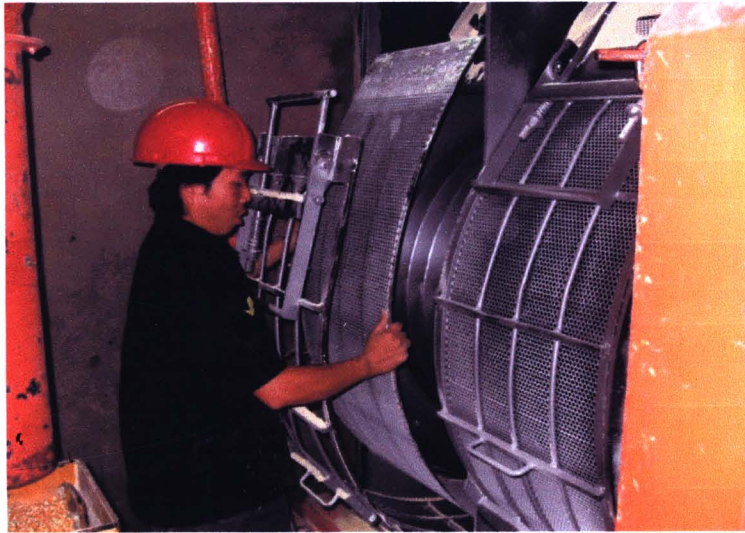
รูป 3.1 พนักงานกำลังเปลี่ยนตะแกรงเครื่องบด
