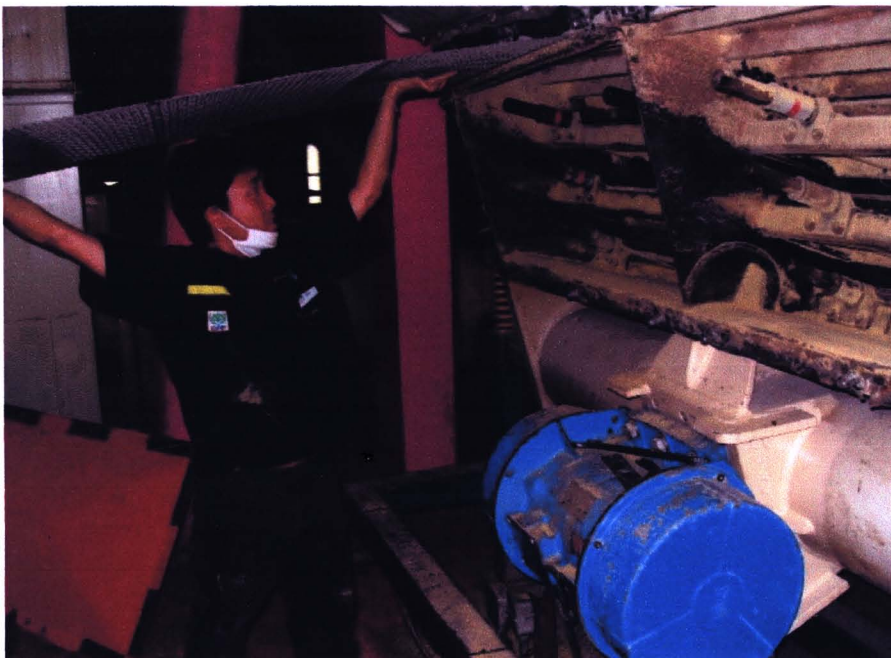
รูปที่ 3.4 พนักงานกำลังเปลี่ยนตะแกรงเครื่องร่อนเม็ด
