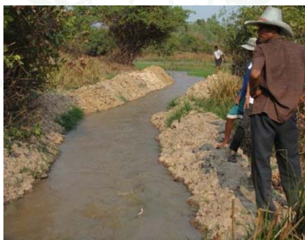
ภาพที่ 57 คลองน้ำที่ใช้รถแมคโฮชุดเพื่อนำน้ำเข้าสู่พื้นที่ทำนา
