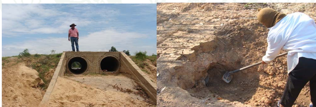
ภาพที่ 54 ท่อคอนกรีตเสริมเหล็กสำหรับระบายน้ำหรือส่งน้ำข้ามแหล่งน้ำหรือถนน
