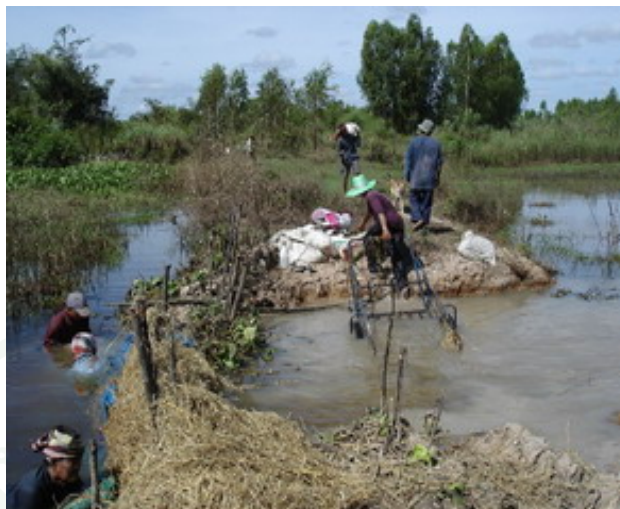
ภาพที่ 60 การทำนบคันดินกักเก็บน้ำภูมิปัญญาชาวบ้าน
