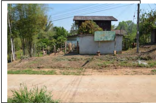
พื้นที่ก่อนทำ
