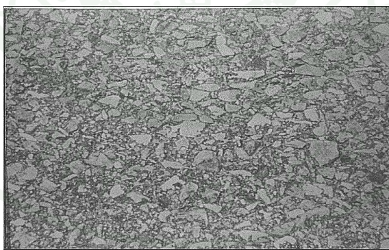
ภาพที่ 11 ความเสียหายแบบ Polished Aggregate
