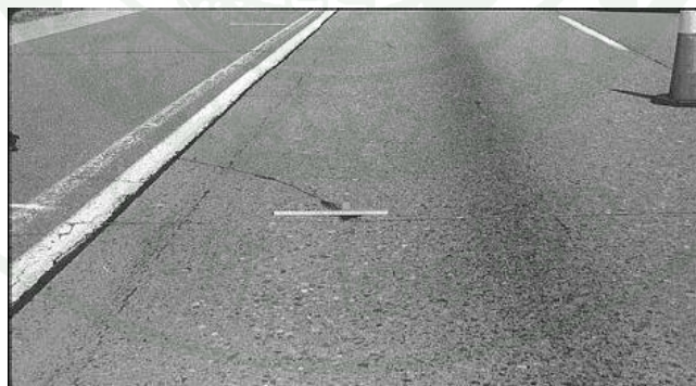
ภาพที่ 16 ความเสียหายแบบ Corner Break
