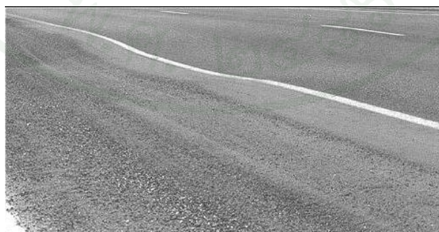
ภาพที่ 8 ความเสียหายแบบ Depression
