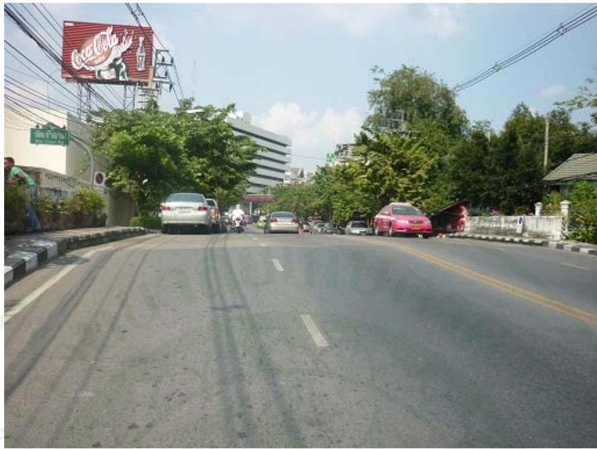
ภาพที่ 45 โครงสร้างส่วนบนของสะพานข้ามคลองวัดเจ้าอาม
