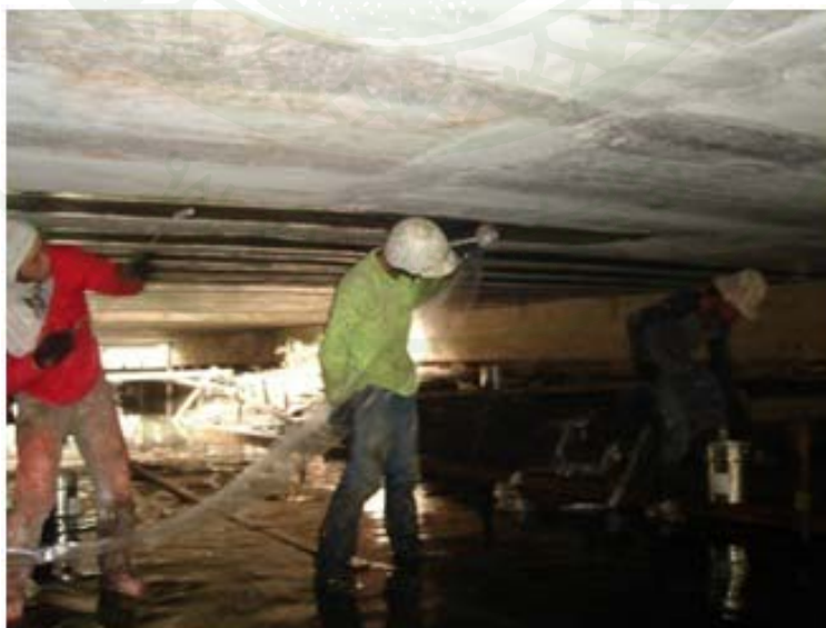
ภาพผนวกที่ ๑๑๑ การรีดแผ่น CFRP เพื่อไล่ฟองอากาศ
