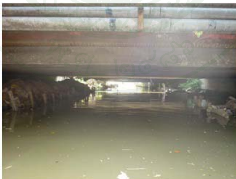
ภาพที่ 35 โครงสร้างส่วนล่างของสะพานข้ามคลองสะพานยาว
