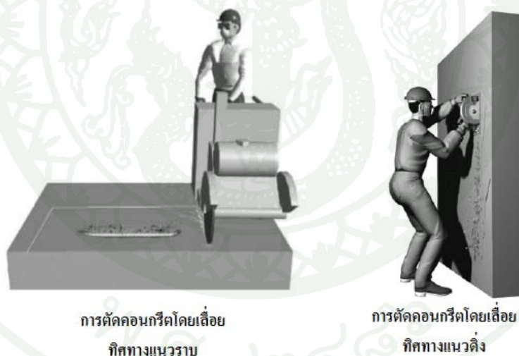
ภาพผนวกที่ ค1 การตัดคอนกรีตโดยเลื่อยตัดทิศทางแนวราบและแนวตั้ง
