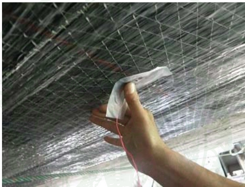
ภาพที่ 54 การติดตั้ง Strain Gauge ตำแหน่ง CFRP
