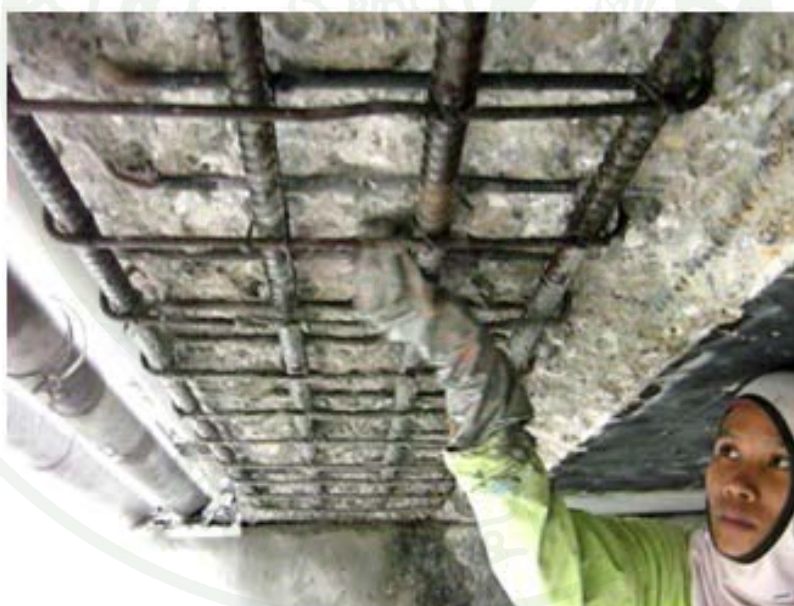
ภาพผนวกที่ ค13 การซ่อมแซมเหล็กเสริมคอนกรีตโดยการต่อทาบเหล็กเสริมใหม่
