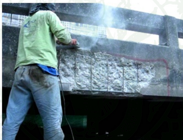
ภาพผนวกที่ ค7 การตัดคอนกรีตด้วยเลื่อยบริเวณที่มีความเสียหายเพื่อทำการซ่อมแซม
