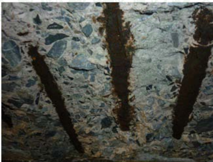
ภาพผนวกที่ ค10 ลักษณะเหล็กเสริมที่ถูกการกัดกร่อนจากสนิม
