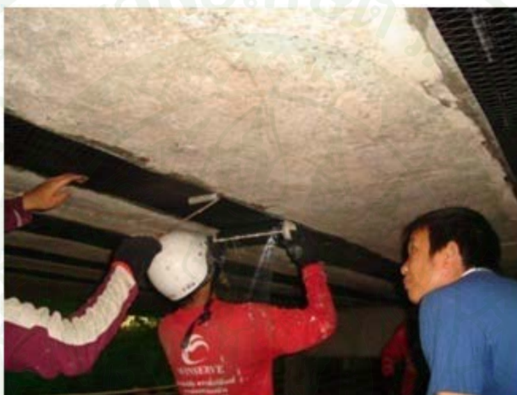
ภาพผนวกที่ ๑๒ การติดตั้ง CFRP ที่มีจำนวนมากกว่า 1 ชั้น
