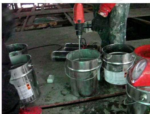
ภาพผนวกที่ ๗ การผสมเรซินด้วยเครื่องกวนไฟฟ้า
