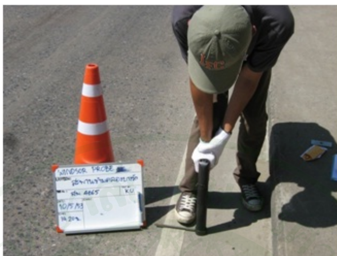
ภาพที่ 29 การทดสอบหาค่ากำลังของคอนกรีตในสนามด้วยการวัดกำลังต้านทานการทะลวง ณ ตำแหน่งพื้นสะพาน
