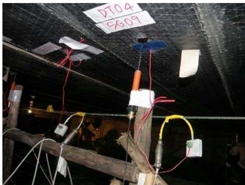
ภาพที่ 55 การติดตั้ง Displacement Transducer ตำแหน่งใต้พื้นสะพาน
