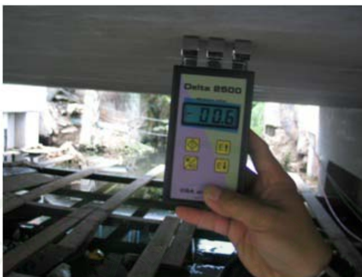
ภาพผนวกที่ ๘ การวัดความชื้นที่ผิวคอนกรีตก่อนการติดตั้ง CFRP ด้วยเครื่อง Moisture Meter
