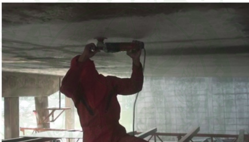
ภาพผนวกที่ ฅ1 การขัดคอนกรีตโดยการใช้เครื่องขัดแบบจานหมุน
