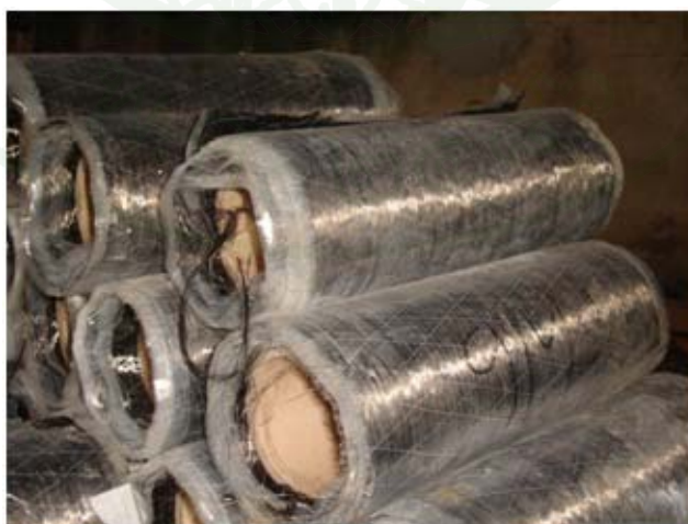
ภาพผนวกที่ น3 การเตรียมปริมาณ CFRP ที่จะนำไปติดตั้ง
