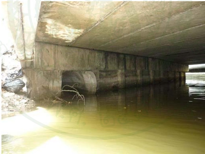
ภาพที่ 46 โครงสร้างส่วนล่างของสะพานข้ามคลองวัดเจ้าอาม
