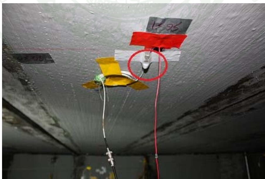
ภาพที่ 56 การติดตั้ง Accelerometer ตำแหน่งใต้พื้นสะพาน
