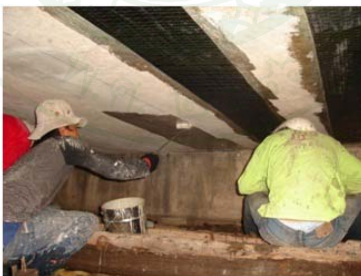
ภาพผนวกที่ ๙ การลงเรซินนำก่อนการติด CFRP
