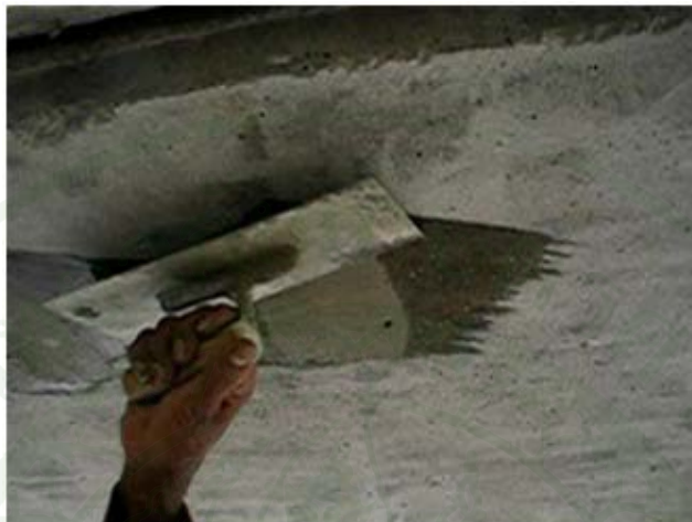
ภาพผนวกที่ น2 การฉาบ (Putty) ปิดผิวคอนกรีตที่มีรูขนาดเล็ก
