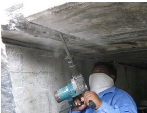
ภาพผนวกที่ ค6 การสกัดคอนกรีตด้วยเครื่องสกัดคอนกรีตแบบกระแทก
