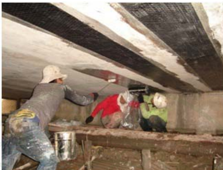
ภาพผนวกที่ ๑๑๐ การติดตั้ง CFRP ตามแนวยาวใต้โครงสร้างพื้นสะพาน
