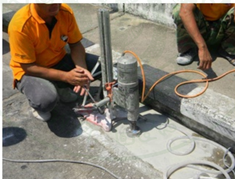
ภาพที่ 23 การเจาะเก็บตัวอย่างคอนกรีตตำแหน่งพื้นสะพานคอนกรีตเสริมเหล็ก
