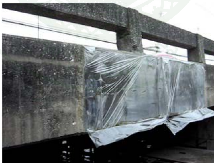
ภาพผนวกที่ ค9 การบ่มวัสดุซ่อมแซมคอนกรีตด้วยวิธีใช้แผ่นพลาสติกคลุม
