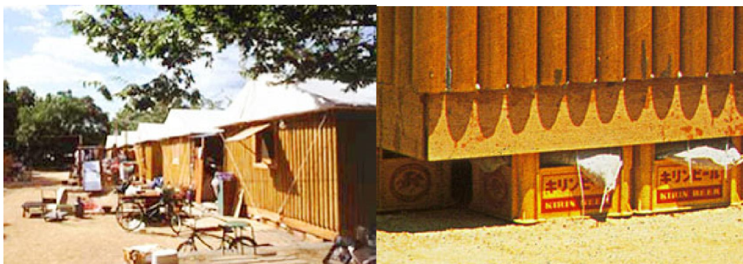
รูปที่ 2.17 แสดงภาพอาคารบ้านพักอาศัยชั่วคราว เมืองโกเบ ที่ก่อสร้างด้วยท่อกระดาศ [5]
