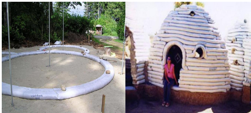
รูปที่ 2.16 บ้านพักอาศัยชั่วคราวที่สร้างด้วยระบบ Super Adobe ของสถาปนิก Nader Khalili (ต่อ)
