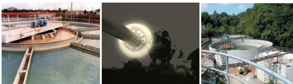
รูปที่ 2.21 อัลตราโซนิกกับเครื่องวัดระดับตะกอน
