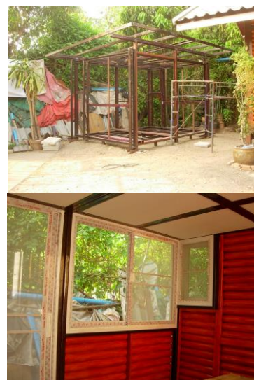
ภาพที่ 7.3 แสดงลักษณะและโครงสร้างงานที่พักอาศัยชั่วคราวฉุกเฉิน
