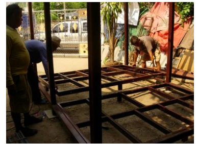
3.ติดตั้งโครงสร้างพื้น
