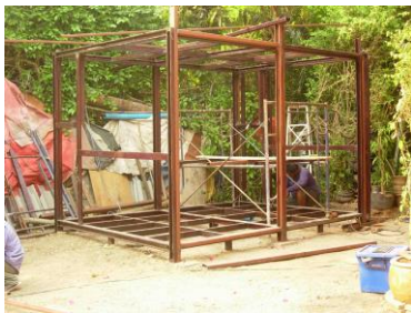
4.ติดตั้ง โครงคร่าวฝ้าเพดาน
