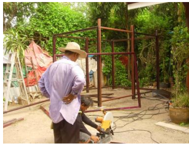
2.ติดตั้งชุดโครงสร้าง
