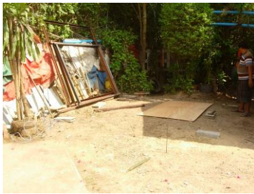
1.ปรับพื้นที่วางฐาน
