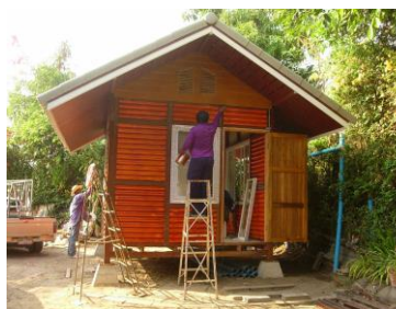
8.การติดตั้งประตู หน้าต่าง
