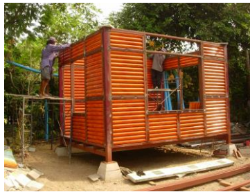
5.การติดตั้งผนัง
