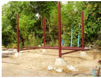
2.การตั้งฐาน เสา
