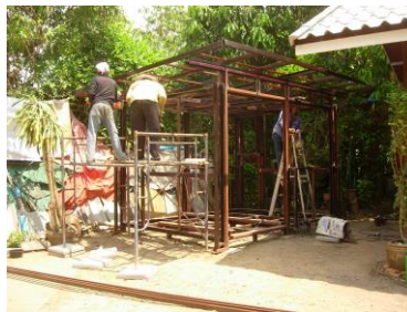
5.การติดตั้ง โครงหลังคา
