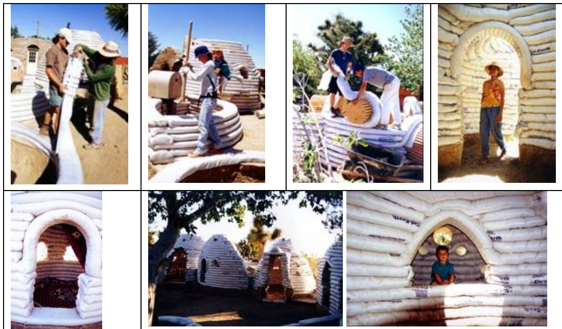
ภาพที่ 3.2 แสดงวิธีการประกอบอาคารพักอาศัยชั่วคราวระบบ Super-Adobe
