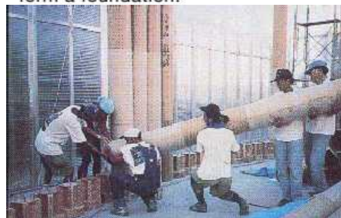
ภาพที่ 3.1 แสดงอาคารพักอาศัยชั่วคราว เมืองโกเบ ที่ก่อสร้างด้วยท่อกระดาษ
