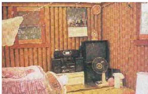
ภาพที่ 3.1 แสดงอาคารพักอาศัยชั่วคราว เมืองโกเบ ที่ก่อสร้างด้วยท่อกระดาษ
