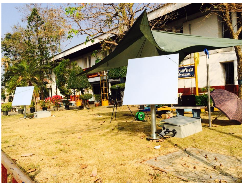
รูปที่ 4.2 การติดตั้งระบบสะท้อนแสงอาทิตย์
