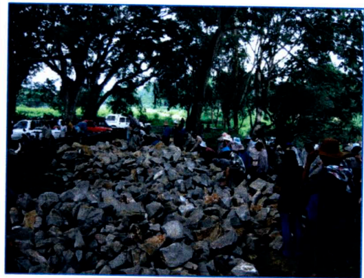
ภาพ 4.17 หินที่นำไปบรรจุในกล่องหิน วัสดุที่ใช้สร้างฝายในปัจจุบัน
