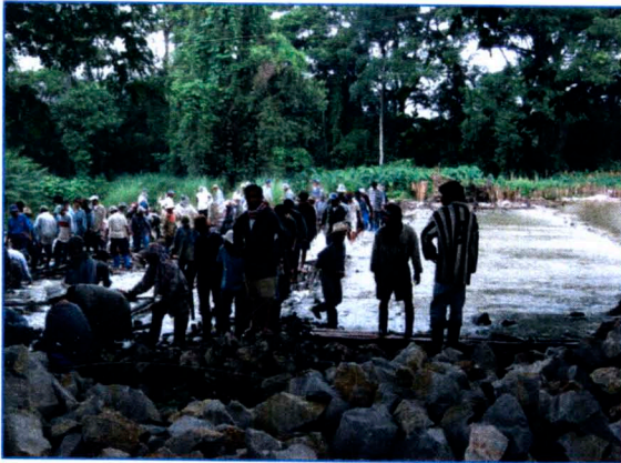
ภาพ 4.18 การนำหินบรรจุในกล่องหิน เพื่อซ่อมแซมฝาย
