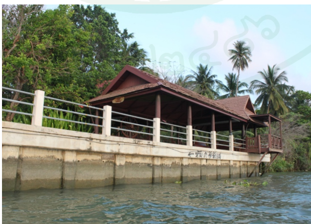
ภาพที่ 16 การสร้างตลิ่งคอนกรีตริมน้ำ
