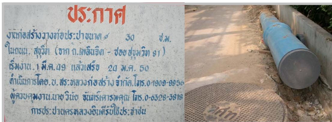
ภาพที่ 4.60 โครงการวางท่อประปาส่งผลให้ต้องรื้อผิวทางเดินบางส่วนเพื่อวางท่อประปา
