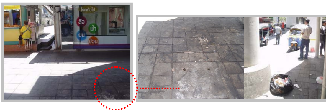
ภาพที่ 4.21 สภาพทางเดินเท้าริมถนนหลัก บริเวณสถานีรถไฟฟ้าสยาม
