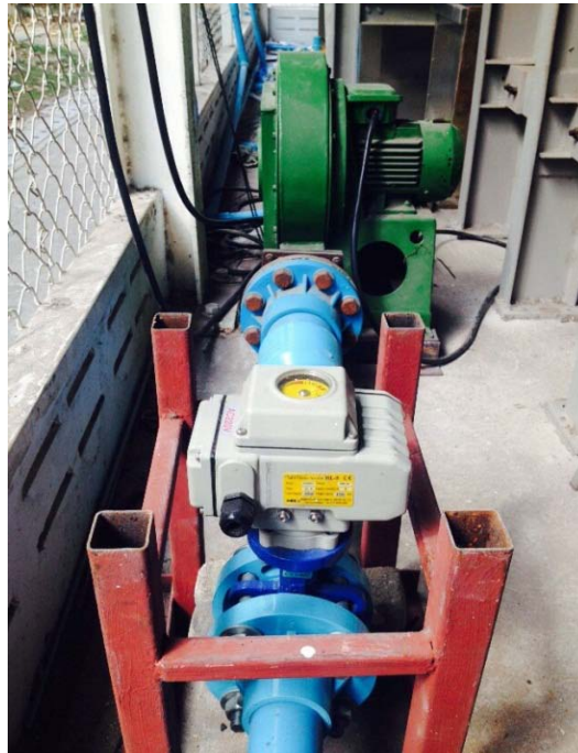
ภาพที่ 5.9 โบลเวอร์ และวาล์วปรับอัตราการไหลอากาศส่วนที่หนึ่ง (primary air)
