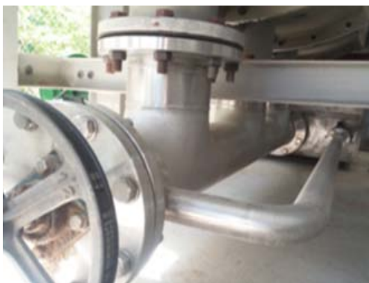
ภาพที่ 5.14 สกรูระบายไอน้ำ และถังพักไอน้ำ
