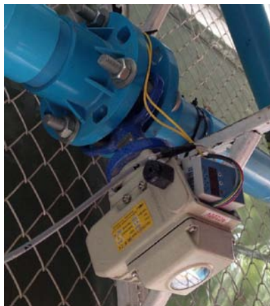
ภาพที่ 5.20 วาล์วปีกผีเสื้อ (butterfly valve) หลังการติดตั้ง
