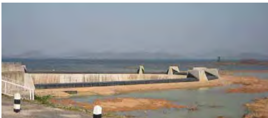
ภาพที่ 45 ลักษณะสภาพของเขื่อนคลองสี่ยัดที่มีส่วนกำหนดปริมาณน้ำในปัจจุบัน (จากการถ่ายภาพของผู้วิจัยในขณะลงสำรวจภาคสนามในพื้นที่บ้านบางมะเฟือง อำเภอสนามชัยเขต จังหวัดฉะเชิงเทรา, พฤศจิกายน 2550)
