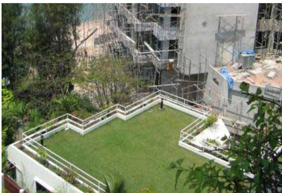
ภาพที่ 30 ภาพแสดงหลังคาเขียวบนอาคารชุดพักผ่อนการ์เดนคลิฟ 2 พัทยา
