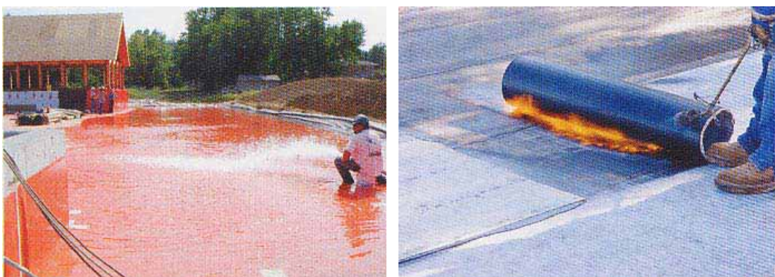
ภาพที่ 9 แสดงขั้นตอนการติดตั้งวัสดุกันน้ำซึม (Water Proof Membrane)
