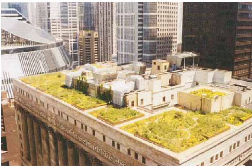
ภาพที่ 6 ภาพ Green roof บนหลังคาอาคาร Chicago City Hall
