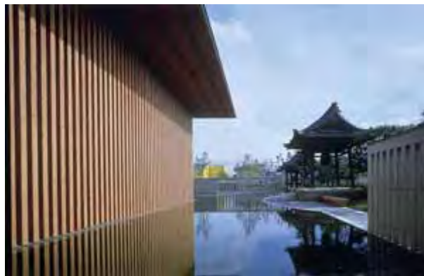
ภาพที่ 80 ตัวอาคารที่เสมือนลอยอยู่บนน้ำ ด้านขวาคือทางเข้าหลัก
