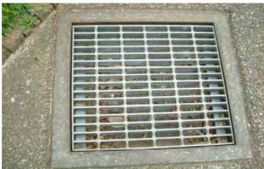
ภาพที่ 17 ตะแกรงท่อน้ำในมีตาข่ายละเอียด เพื่อให้ผู้พิการรถเข็น หรือจักรยานวิ่งผ่านได้
