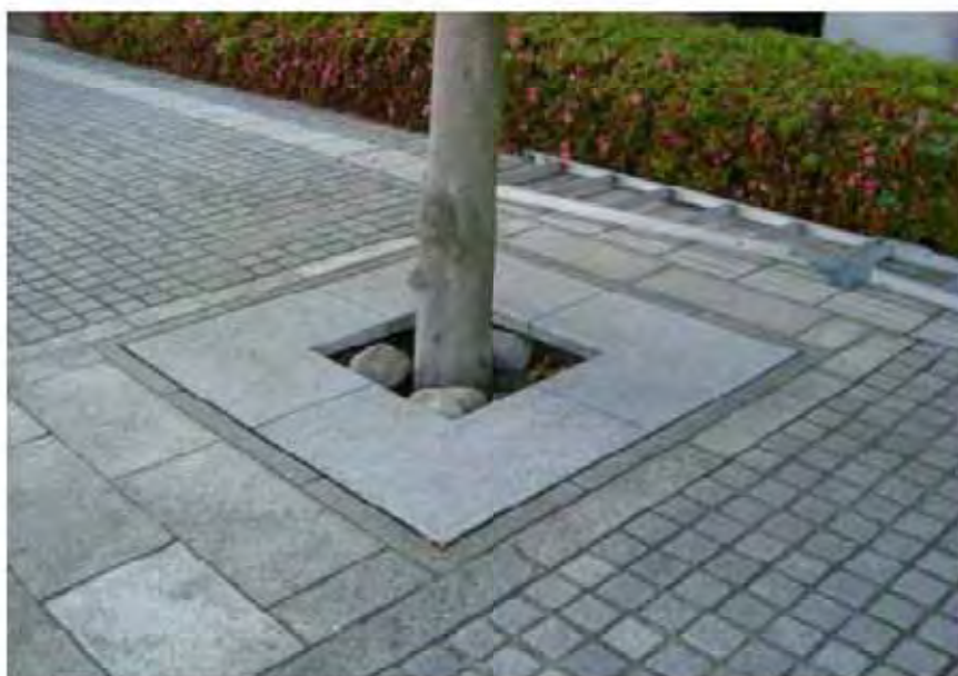
ภาพที่ 18 แผ่นพื้นและแผ่นปิดหน้าดินสำหรับต้นไม้ออกแบบเพื่อให้ผู้พิการรถเข็น หรือจักรยานวิ่งผ่านได้
