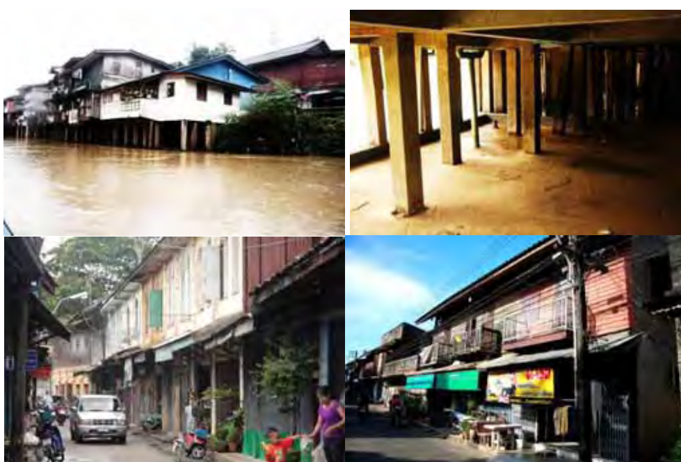
ภาพที่ 6 ลักษณะการปลูกสร้างบ้านเรือนริมน้ำในปัจจุบัน
