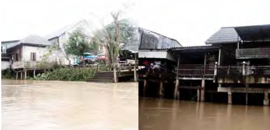
ภาพที่ 27 ลักษณะของอาคารบ้านเรือนที่อยู่ริมน้ำ
