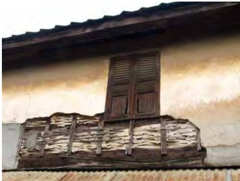
ภาพที่ 222 อาคารที่ก่อสร้างด้วยไม้ไผ่สานโบกปูนแบบอย่างจีน สามารถพบได้ที่บริเวณ หน้าวัดหลวงราชवास (สมัยที่ยังไม่ทำเป็นคอนกรีตเสริมเหล็ก)
