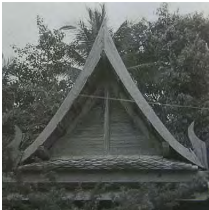
ภาพที่ 288 ลักษณะของหน้าจั่วแบบตีฝากระดานเป็นเกล็ด ที่วัดมะกอก
