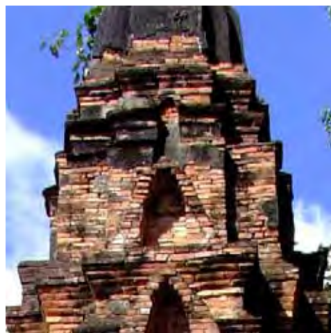
ภาพที่ 110 จระนำซุ้ม เรือนธาตุชั้นที่ 2 พระธาตุวัดเทพพลฯ องค์ทิศเหนือ จังหวัดหนองคาย
