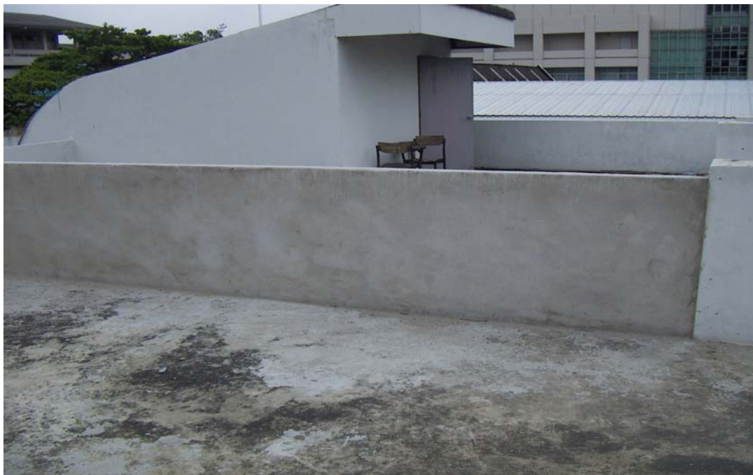
ภาพที่ 28 ผนังคอนกรีตบล็อกฉาบปูนสองด้าน
