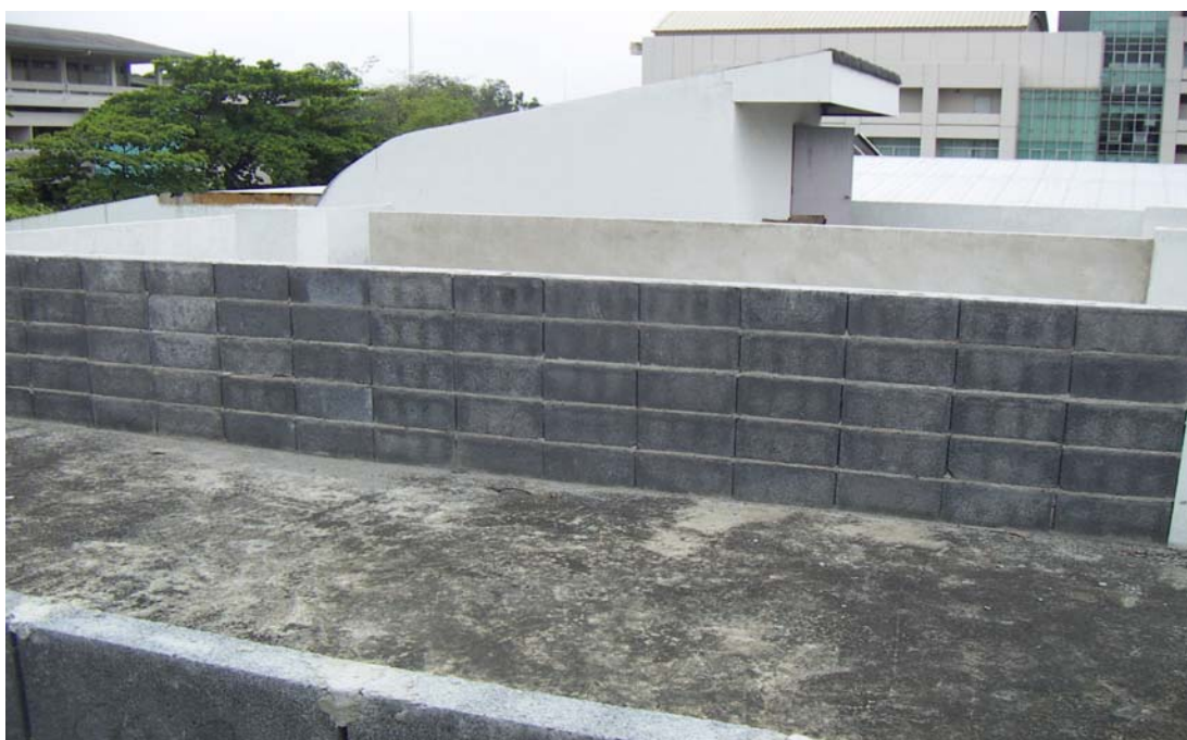
ภาพที่ 27 ผนังคอนกรีตบล็อกฉาบปูนหนึ่งด้าน
