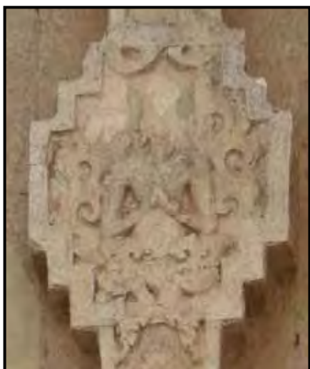
ภาพที่ ๑๐๙ ลายกรอบสี่เหลี่ยมย่อมุม เสาอุก มะหวดเหลี่ยม ด้านหลังอุโบสถ วัดไชย จ.ลพบุรี
