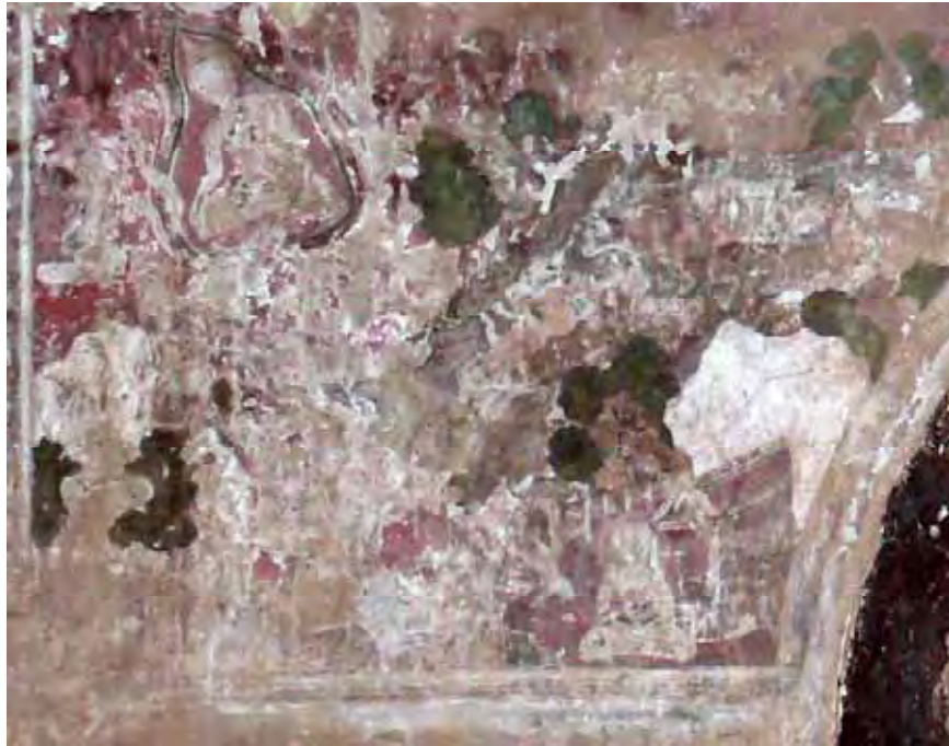
ภาพที่ 123 สันนิษฐานว่าซ่อมเพิ่มเติมภายหลัง
