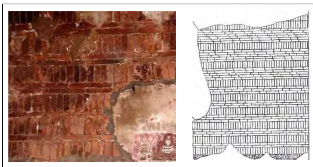
ภาพที่ 7 ลักษณะการก่ออิฐบริเวณส่วนโค้งของเพดาน เป็นแบบแนวนอน (stretcher Bond) สลับกับแนวตั้ง ผนังเพดานบริเวณด้านข้างภายในกุฎจตุรพักตรพิมาน
