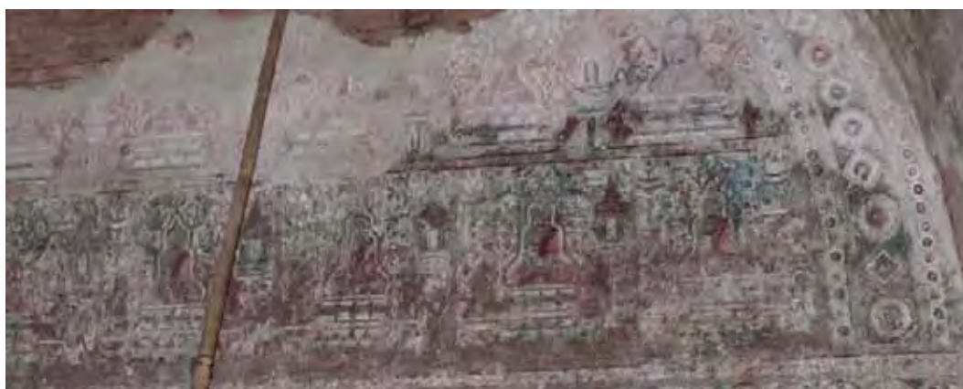
ภาพที่ 55 ผนัง 9 W (บ.) ผนังส่วนบน เหนือประตูทางเข้าด้านทิศตะวันตก
