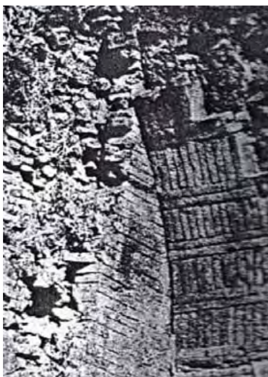
ภาพที่ 9 การก่ออิฐแนวอนแบบ Strecher Bond สลับกับแนวตั้ง บริเวณส่วนโค้งของเพดาน ภายในเจดีย์วิหารนากายน ณ หมู่บ้านมยิงกาบา เมืองพุกาม
