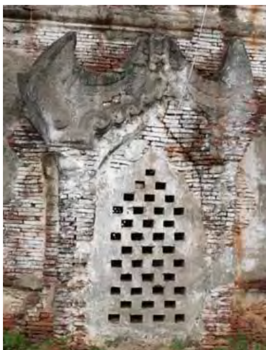
ภาพที่ 3 ลักษณะการเรียงอิฐแบบสันโค้งก่อเหลี่ยม (Corbelled Arch)
