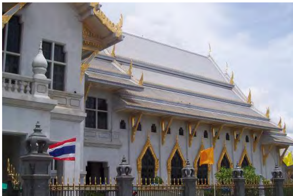
ภาพที่ 2 หลังคาพระอุโบสถด้านทิศใต้
