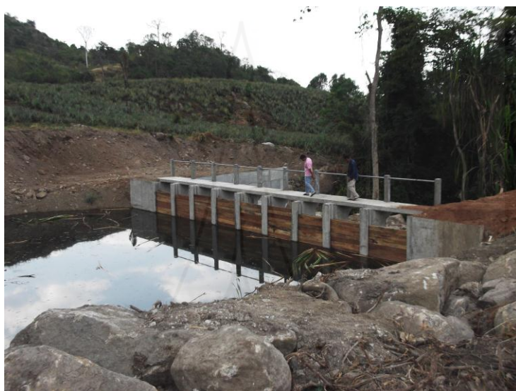
ภาพที่ 4.14 ฝ่ายกักเก็บน้ำแบบถาวร บ้านบางกะม่า
