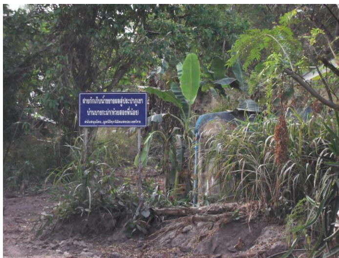
ภาพที่ 4.13 บริเวณฝายกักเก็บน้ำและประปาภูเขาบ้านบางกะมา
