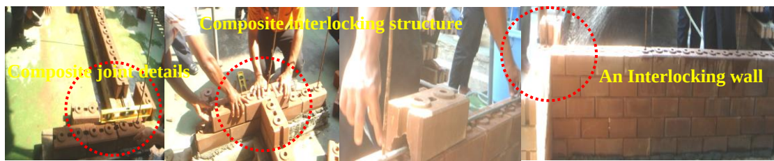
รูปที่ 68. ตัวอย่างแสดงการสาธิตจุดต่อเสาและผนังแบบรับแรง(Interlocking-Load bearing wall)
