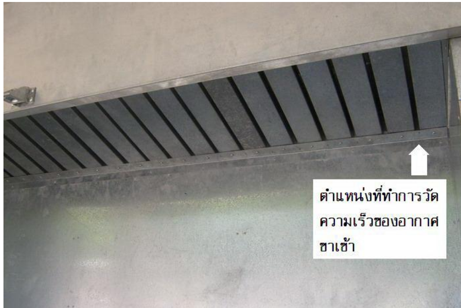
ภาพที่ 4.1 ตำแหน่งการวัดความเร็วลมและอุณหภูมิด้านขาเข้า
