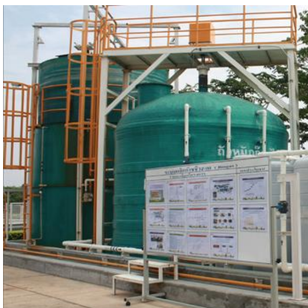
ภาพที่ 6.6 ถังหมักก๊าซชีวภาพจากเศษอาหารของ โรงงานประกอบรถยนต์โตโยต้า บ้านโพธิ์ จังหวัดฉะเชิงเทรา
