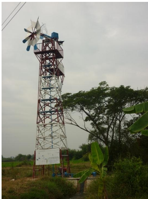
ภาพที่ ค.12 กังหันลมสูบน้ำระดับชุมชน บ้านดอนผิงแดด
