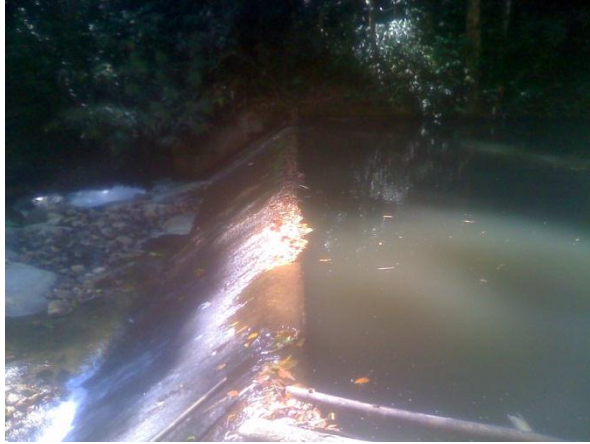
ภาพที่ ง.2 ฝ่ายน้ำล้นสำหรับเก็บกักน้ำเพื่อผลิตกระแสไฟฟ้าให้กับโรงไฟฟ้าพลังน้ำแม่มอญ
