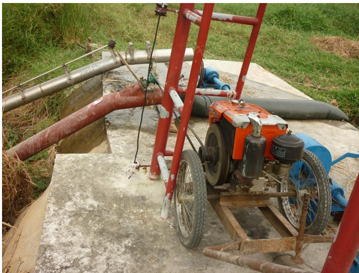
ภาพที่ ค.13 การติดตั้งเครื่องสูบน้ำพลังงานน้ำมันเชื้อเพลิง เพื่อใช้ในกรณีที่กังหันลมสูบน้ำไม่สามารถดำเนินการได้
