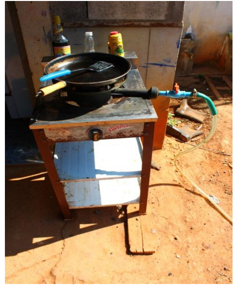
ภาพที่ ค.9 การต่อก๊าซชีวภาพเพื่อใช้ในร้านค้าสวัสดิการชุมชนหมู่บ้านภูไทพัฒนา
