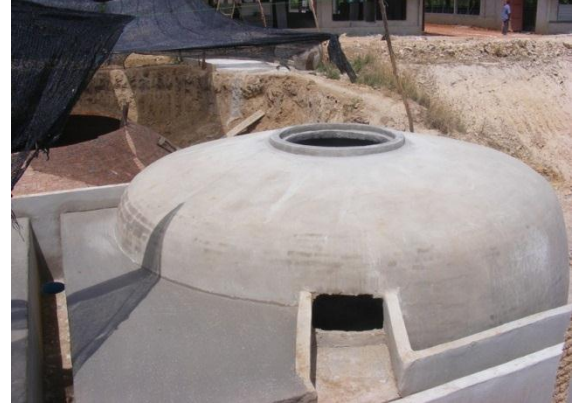
ภาพที่ จ.2 การผลิตก๊าซชีวภาพจากมูลสัตว์ของฟาร์มเลี้ยงสุกรภาคเอกชนในพื้นที่องค์การบริหารส่วนตำบลวังจันทร์ อำเภอแก่งกระจาน จังหวัดเพชรบุรี
