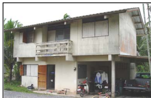
ภาพที่ 79 บ้านพักโครงสร้าง คสล. 2 ชั้น
